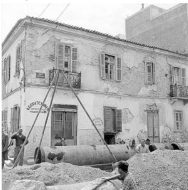
Εικ.2.3 Τοποθέτηση αγωγού εντός πόλεως 1953 ©Αρχείο ΕΥΔΑΠ
