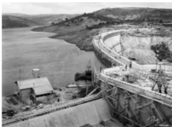
Εικ. 2.1 Στάδιο κατασκευής φράγματος Μαραθώνα. ©LeoValanos
