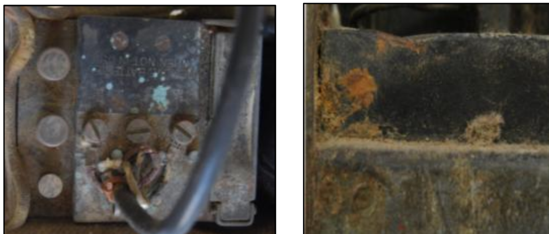
Εικ.4.26 Λεπτομέρειες από την άνω πλευρά του μεταλλικού πλαισίου. Παρατηρούνται έγχρωμες (γαλάζιες) κηλίδες και κρούστες επικαθίσεων (αριστερά). Συμπαγές στρώμα επικαθίσεων σκόνης, ατμοσφαιρικών ρύπων και χρώματος (δεξιά) ©Μουσείο ΕΥΔΑΠ, φωτογραφία Αλεξάνδρα Μπολότη
