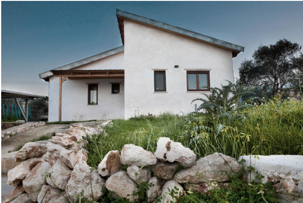
Εικ.2.35 Κατοικία 125 m 2 στα Χανιά, Southern architects. Κατασκευή από ξύλινο σκελετό και τοιχοποιία από μείγμα αχυροπηλού πάχους 35εκ. Εξωτερικά έχει επιχρισθεί με ασβεστοκονίαμα και εσωτερικά με πηλοκονίαμα. Το μέσο θέρμανσης που διαθέτει είναι ενεργειακό τζάκι, ενώ δεν έχουν χρησιμοποιηθεί μηχανικά μέσα ψύξης. ΠΗΓΗ: https://www.southernarchitects.gr
