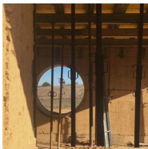
Εικ.2.33,34 Κατοικία υπό κατασκευή, με την τεχνική συμπιεσμένου χώματος, Santiago do Cacem Πορτογαλία ΠΗΓΗ: προσωπικό αρχείο
