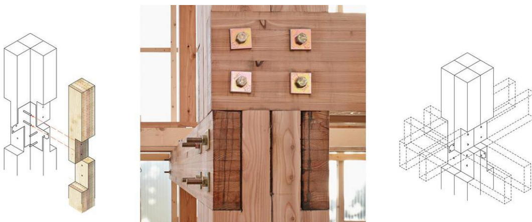
Εικ. 1.4 Λεπτομέρεια συνδεσμολογίας που ακολουθεί μια από τις θεμελιώδεις αρχές του DfD: την δημιουργία προσβάσιμων και κατάλληλων συνδέσεων για διευκόλυνση της αποσυναρμολόγησης και αποφυγή της χρήσης βαρέως ή πολύπλοκου εξοπλισμού. Kengo Kuma & Associates + College of Environmental Design UC Berkeley © Shinkenchiku Sha ΠΗΓΗ: A Guide to Design for Disassembly | ArchDaily
