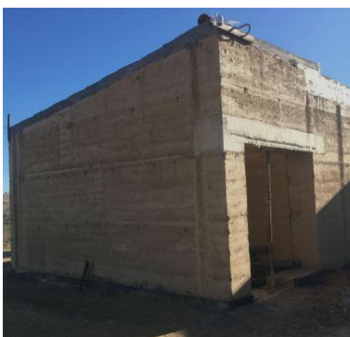
Εικ.2.33,34 Κατοικία υπό κατασκευή, με την τεχνική συμπιεσμένου χώματος, Santiago do Cacem Πορτογαλία ΠΗΓΗ: προσωπικό αρχείο
