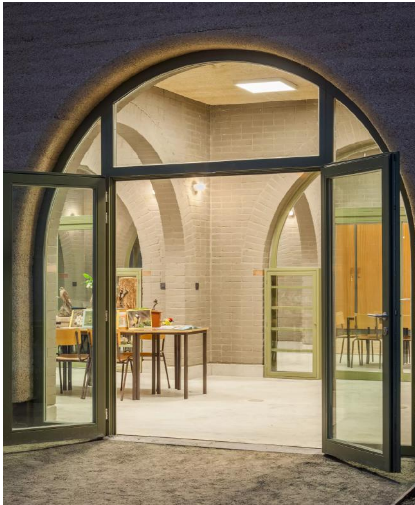
Εικ.2.3 Fort V, (2015), Έργο των BC architects που λειτουργεί σαν εκπαιδευτικό κέντρο και αποτελεί το πρώτο δημόσιο κτίριο με φέροντες τοίχους από CEB, στην Benelux. © Thomas Noceto ΠΗΓΗ: https://architects.bc-as.org/
