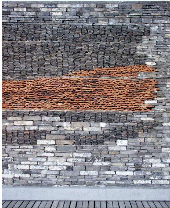
Εικ.1.5,6,7 Μουσείο Ιστορίας Ningbo, Amateur Architecture Studio. Έργο του 2008 που ενσωματώνει στον σχεδιασμό του υλικά από τα κατεδαφισμένα κτίρια που υπήρχαν στο σημείο κατασκευής του. ΠΗΓΗ: https://www.archdaily.com/942622/wang-shus-works-on-contemporary-chinese-architecture-with-recycled-materials
