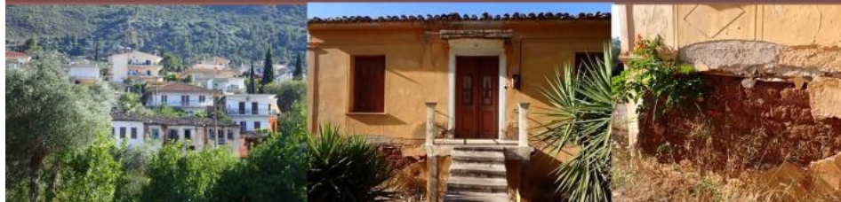
Εικ.2.6,7 Κτίρια κατασκευασμένα με ωμό πηλό στην Πελοπόννησο.
