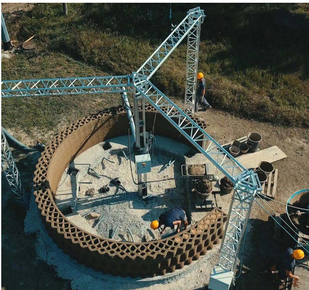
Εικ.2.17,18,19 Εξωτερική άποψη. Τρισδιάστατο επεξηγηματικό διάγραμμα κατασκευής Φωτογραφία την στιγμή της κατασκευής ΠΗΓΗ: https://www.3dwasp.com/en/3d-printed-house-gaia/
