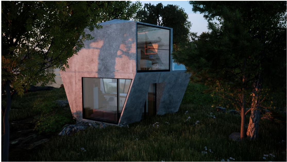
Εικόνα 72 Δυτική Όψη κατοικίας
