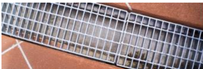
Εικόνα 101 Σχάρες στις υδρορροές για συγκράτηση
