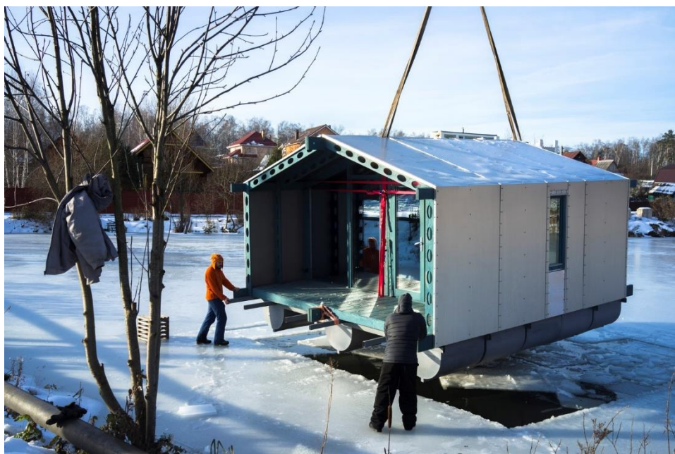
Εικόνα 27 Διαδικασία τοποθέτησης του DD16
