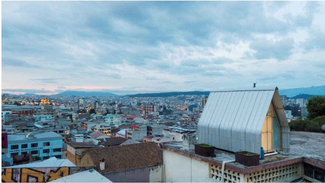
Εικόνα 14 Τοποθεσία του Parasite House
