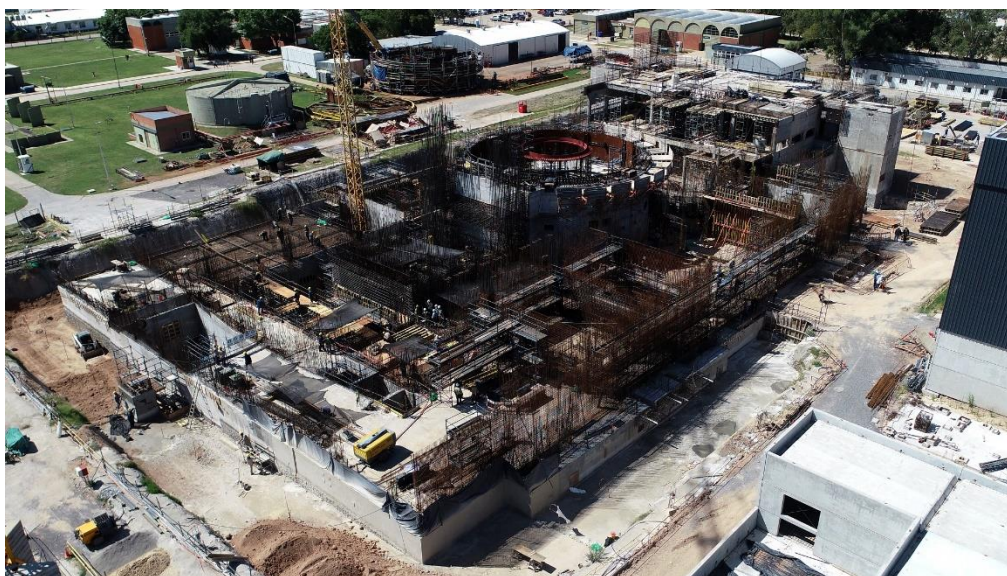
Εικόνα 29 Ο CAREM SMR υπό κατασκευή στο πυρηνικό σύμπλεγμα Atucha στην Αργεντινή (Argentina.gob, χ.χ.)
