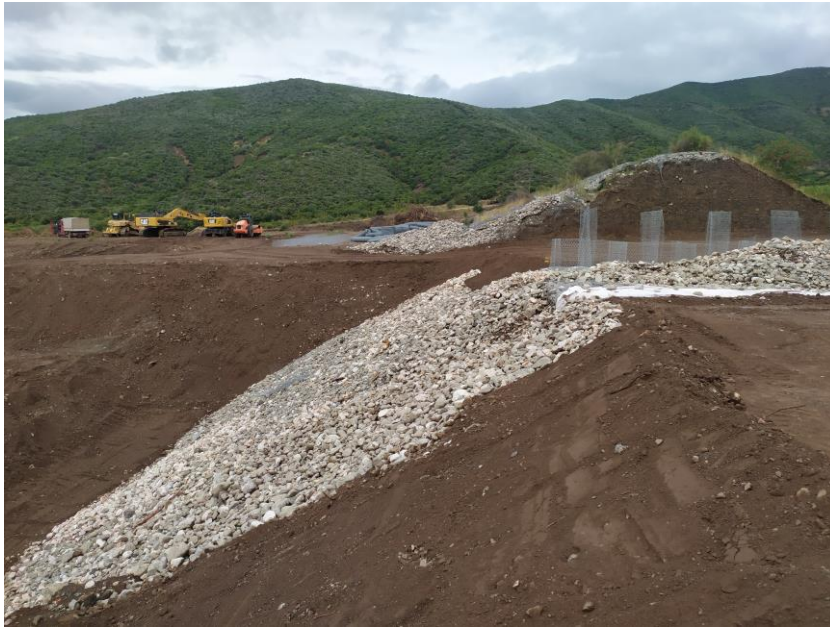
Εικόνα 12: ΤΟΠΟΘΕΤΗΣΗ ΣΥΡΜΑΤΟΠΛΕΓΜΑΤΩΝ ΑΝΑΝΤΙ ΤΟΥ ΦΡΑΓΜΑΤΟΣ
