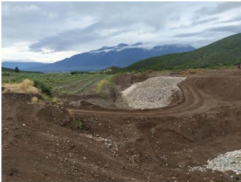
Εικόνα 5: ΔΗΜΙΟΥΡΓΙΑ ΑΝΑΧΩΜΑΤΩΝ
