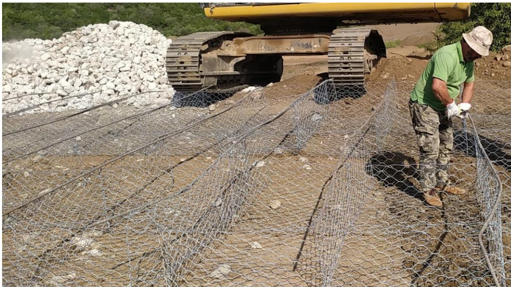
Εικόνα 9: ΚΑΤΑΣΚΕΥΗ ΣΥΡΜΑΤΟΠΛΕΓΜΑΤΩΝ
