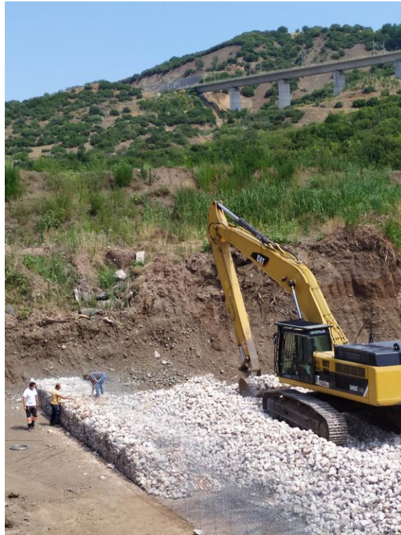
Εικόνα 10: ΤΟΠΟΘΕΤΗΣΗ ΠΛΗΡΩΣΗΣ ΦΑΤΝΩΝ
