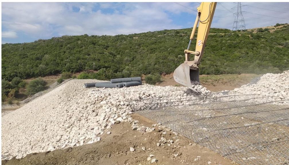
Εικόνα 11: ΤΟΠΟΘΕΤΗΣΗ ΛΙΘΟΠΛΗΡΩΣΗΣ ΣΥΡΜΑΤΟΠΛΕΓΜΑΤΩΝ
