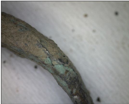
Φωτ. 6.90 Απολεπίσεις και προϊόντα διάβρωσης χαλκού (ανοιχτό πράσινο), ενεργός διάβρωση (x50), (Τρουλλινού Α.°)
