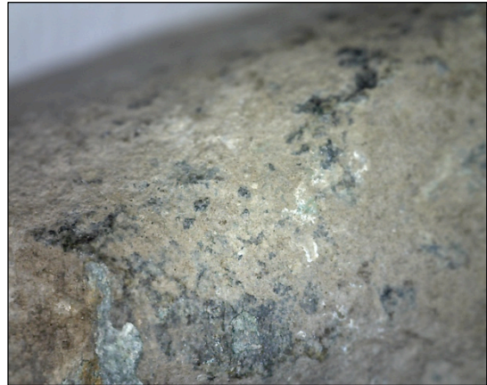
Φωτ. 6.83 Γαλαζοπράσινα προϊόντα διάβρωσης χαλκού (x65), (Τρουλλινού Α.ᶜ)
