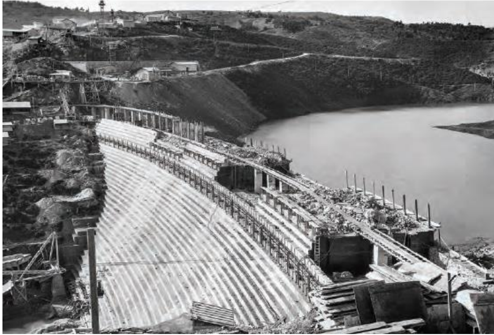
Εικόνα 1.1 Κατά την κατασκευή του Φράγματος (1928). Πηγή: Υδάτινη Ιστοριογραφία. Αρχείο ΕΥΔΑΠ
