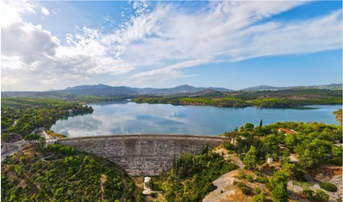
Εικόνα 1.5 Φράγμα Μαραθώνα. Πηγή:
