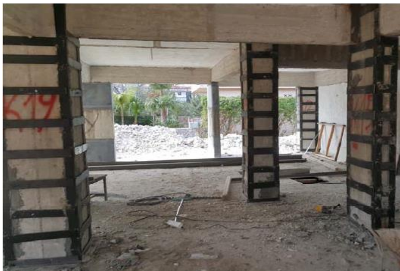
Σχήμα 4.6 Ενίσχυση υποστύλωματος με μεταλλικό κλωβό ( http://www.eandas.gr/el/arkiki/17-ypiresies?start=6 )
