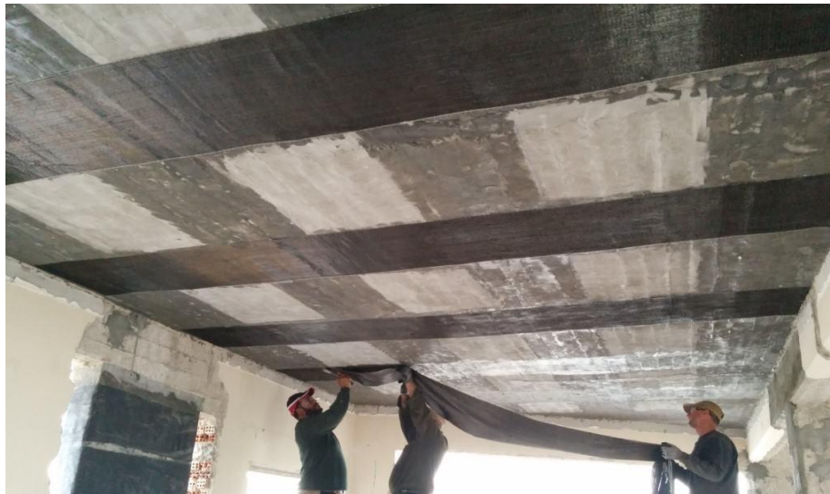
Σχήμα 4.26 Ενίσχυση πλάκας με FRPs ( Ενίσχυση πλάκας με ανθρακούφασματα - Κατοικία στο Αγρίνιο - em4c.gr )
