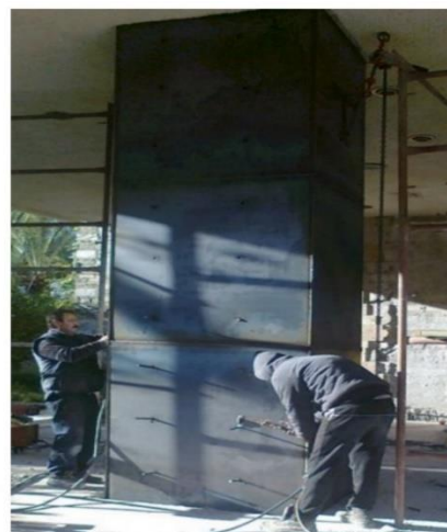
Σχήμα 4.7 Ενίσχυση υποστύλωματος με ολόσωμο μεταλλικό μανδύα ( http://www.eandas.gr/el/arkiki/17-ypiresies?start=6 )
