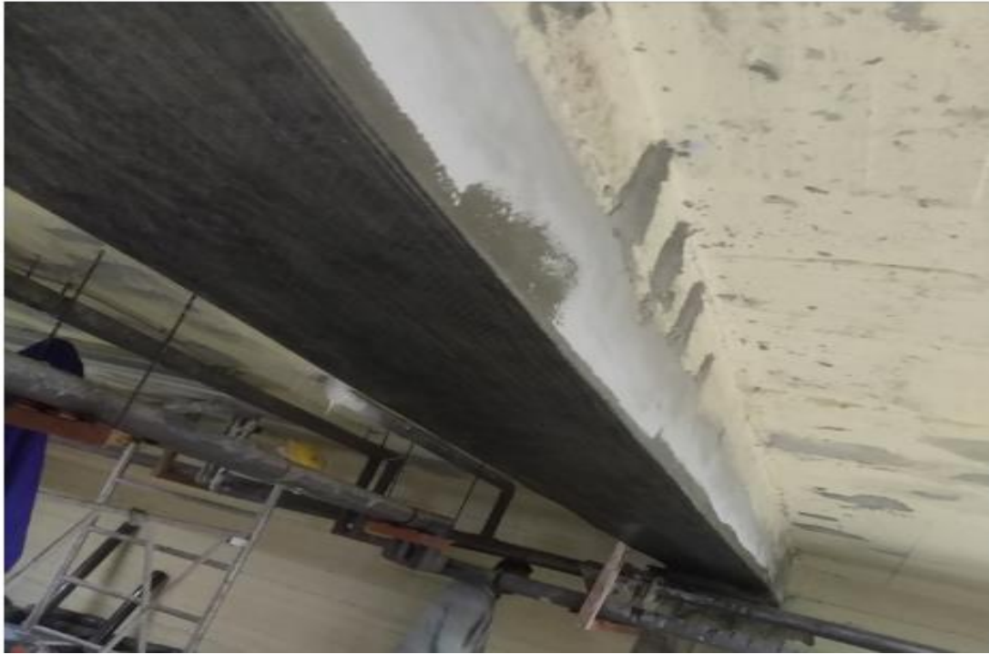
Σχήμα 4.15 Ενίσχυση δοκού με υφάσματα ιοπ παράλληλα στον άξονα του μέλους με σκοπό την αύξηση καμπτικής αντοχής ( https://em4c.gr/portfolio/dimos-iliou/ )
