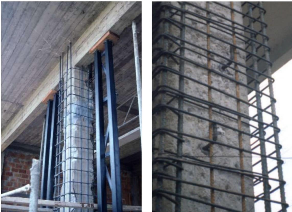
Σχήμα 4.2 Ενίσχυση υποστυλώματος με μανδύες ΟΣ ( http://www.episkeves2.civil.upatras.gr/ )
