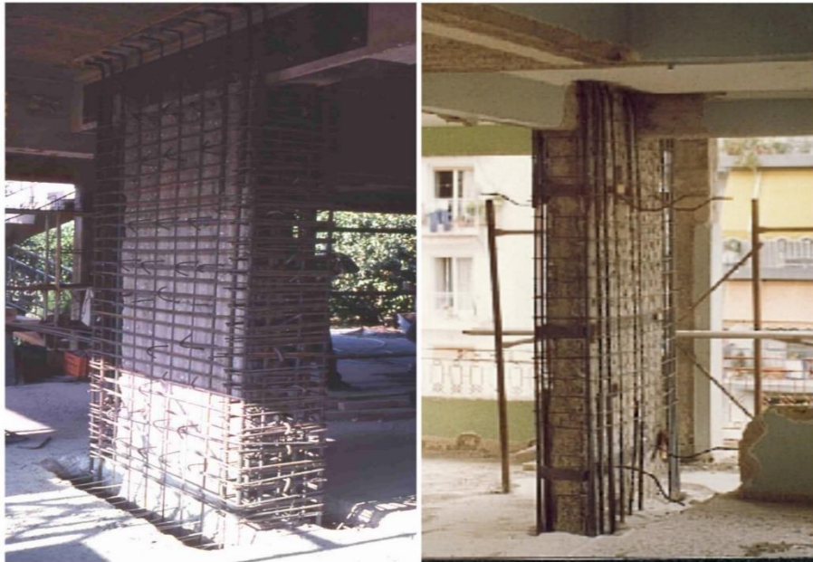
Σχήμα 4.29 Ενισχύσεις Τοιχωμάτων με μανδύα ΟΣ http://www.episkeves2.civil.upatras.gr/?page_id=1026
