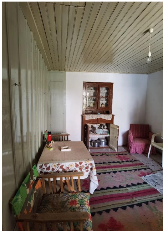
Στο βάθος το ερμάριο που είναι χωνευτό μέσα στον τοίχο. Συναντάται κατά κανόνα στον χώρο του χειμωνιάτικου.
