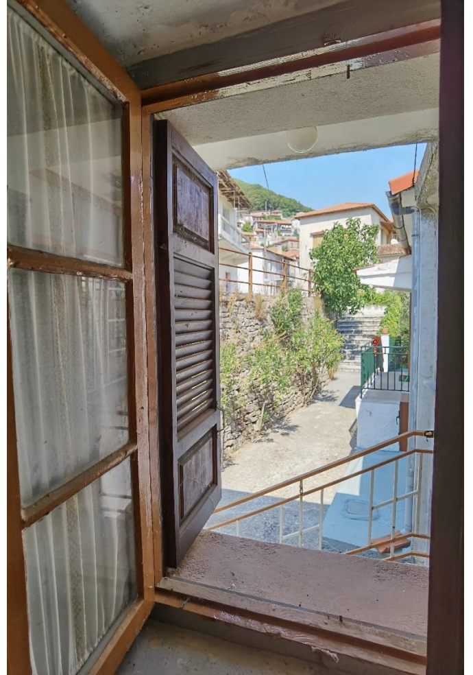
Εσωτερική όψη ανοιγμάτων
