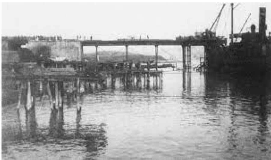
Εικόνα 75: Η Γαλλική σκάλα φορτοεκφόρτωσης μεταλλεύματος ( emel.gr, 2023 )
