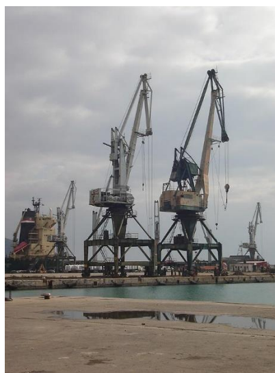
Εικόνα 6 Γερανοί στον λιμένα Βόλου
