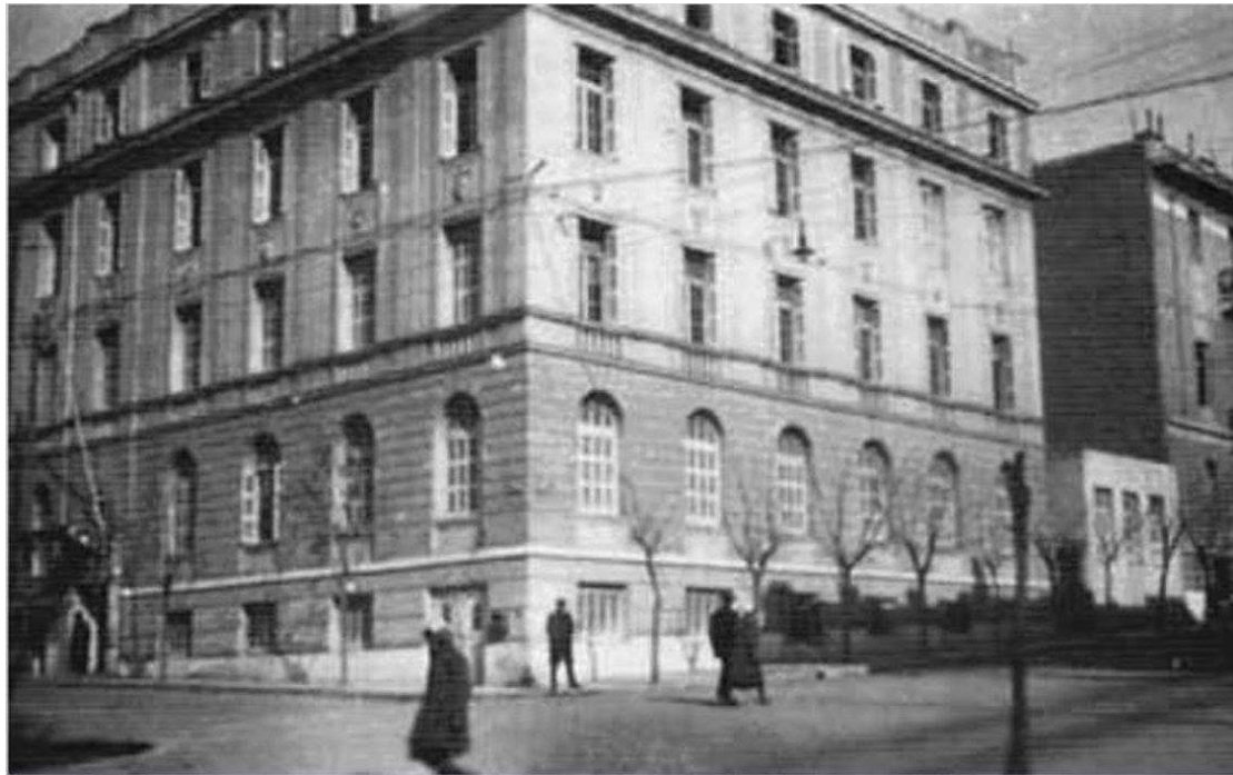
Εικόνα 2.68: Το κτήριο της στρατιωτικής ιατρικής σχολής στο κέντρο της Αθήνας
