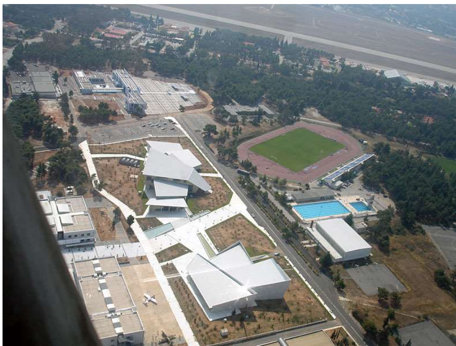
Εικόνα 5.75: Πανοραμική φωτογραφία των εγκαταστάσεων της Σχολής Ικάρων
