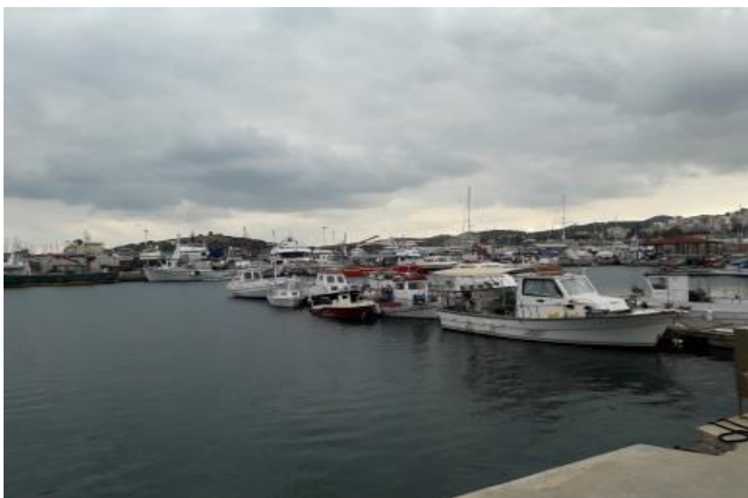
Εικόνα 12: Το αλιευτικό καταφύγιο του λιμένα Λαυρίου
