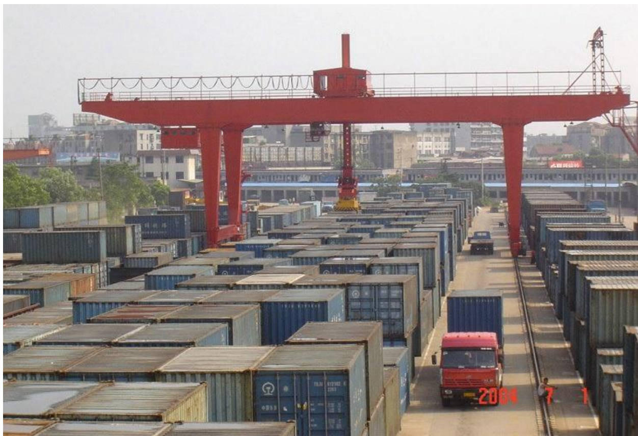
Εικόνα 25 - Rail Mounted Gantry (RMG)
