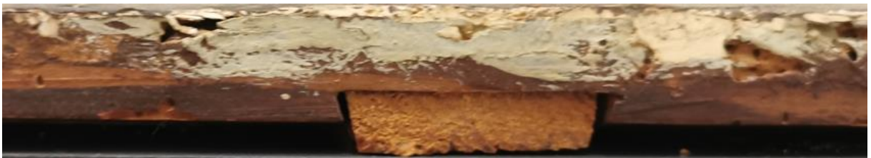
Εικόνα 1-48: Συμπλήρωση στο πλαϊνό σόκκορο
