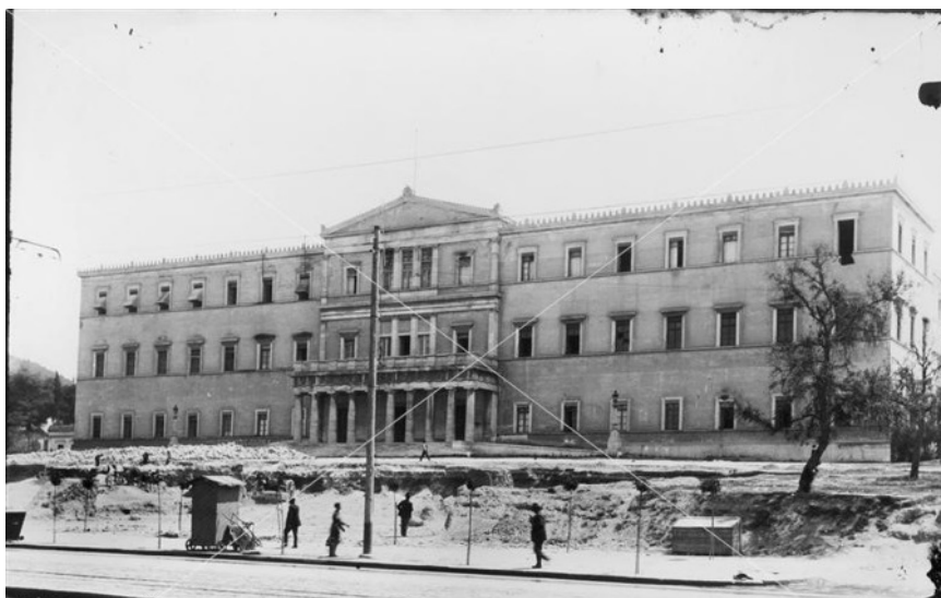
Εικόνα 36: Εργασίες κατασκευής στα Παλιά ανάκτορα (Διαμόρφωση Πλατείας Συντάγματος
