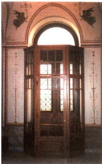
Εικόνα 18. Εσωτερικό πόρτας (είσοδος)
