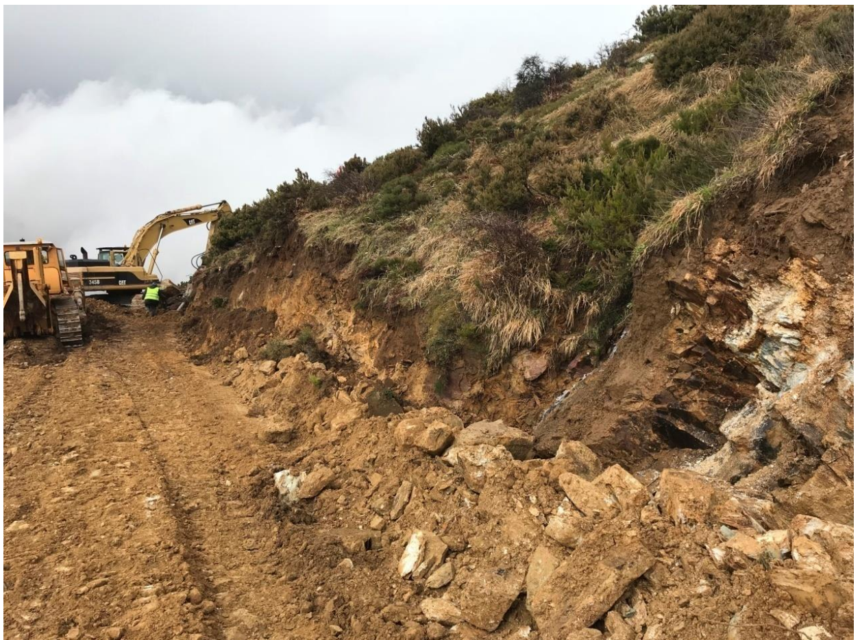
Φωτογραφία 1 : Διάνοιξη δρόμου
