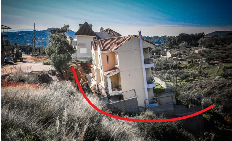
Εικόνα 2.8 – Περιστροφική ολίσθηση που σημειώθηκε το 2022 στην περιοχή του Νέου Βουτζά, Ελλάδα (protothema.gr)
