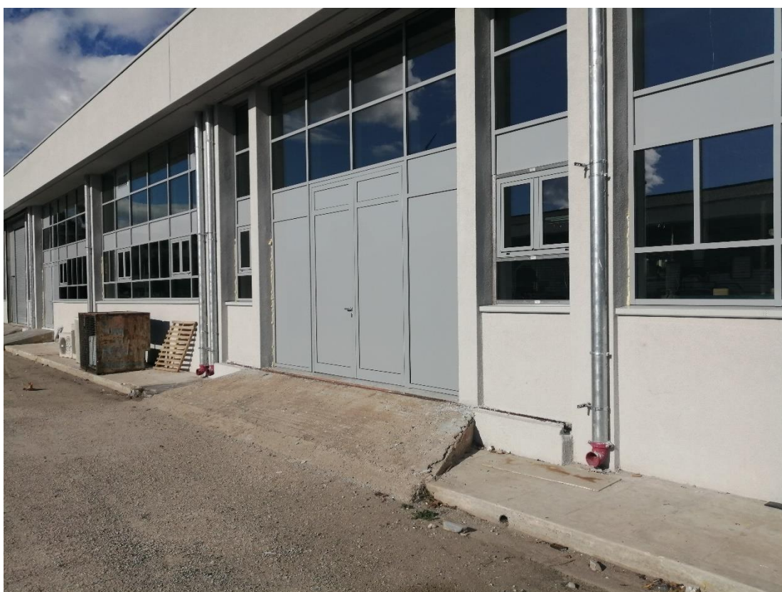
Εικόνα 24 α,β : Άλλη όψη λεπτομέρεια του κτιρίου πριν και μετά την αναβάθμιση
