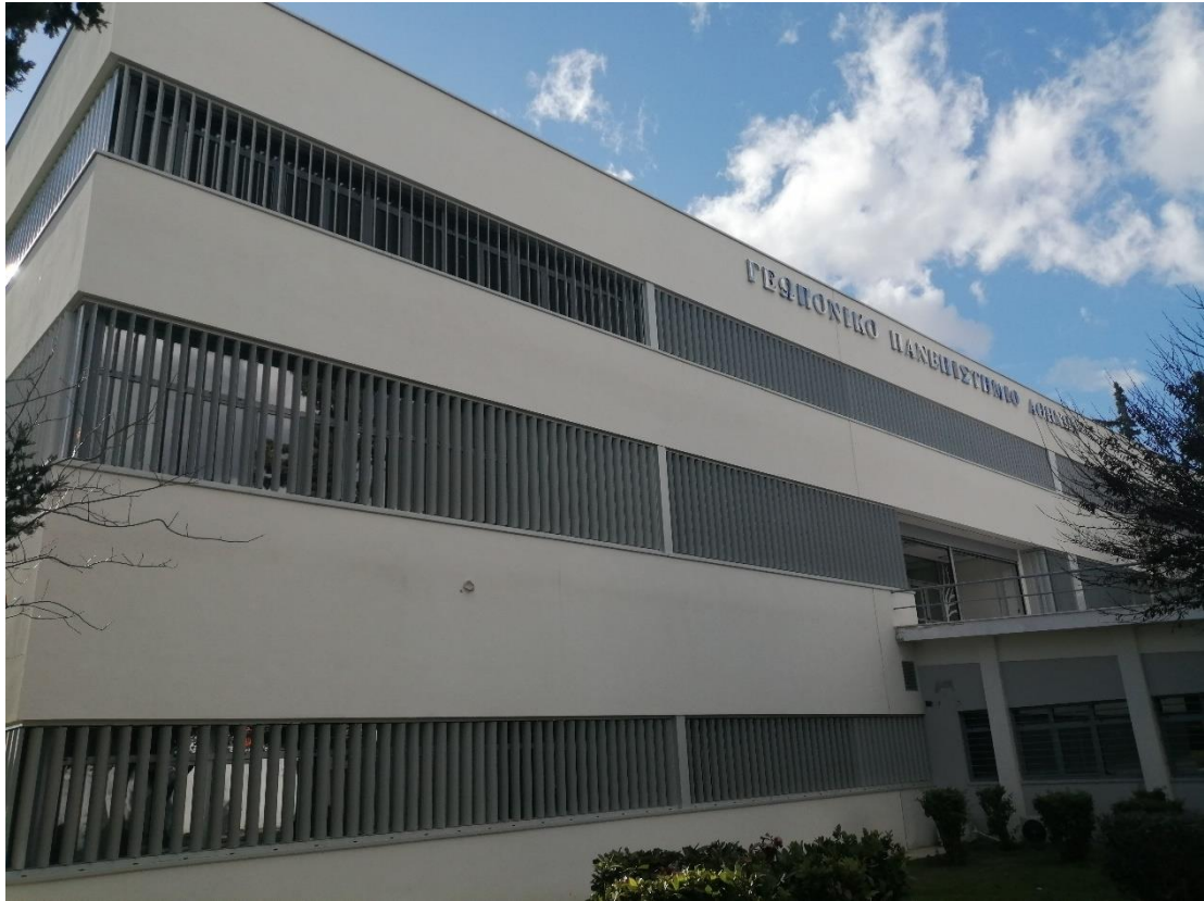
Εικόνα 25 α,β,γ: Ευρύτερη εικόνα του κτιρίου μετά την αναβάθμιση
