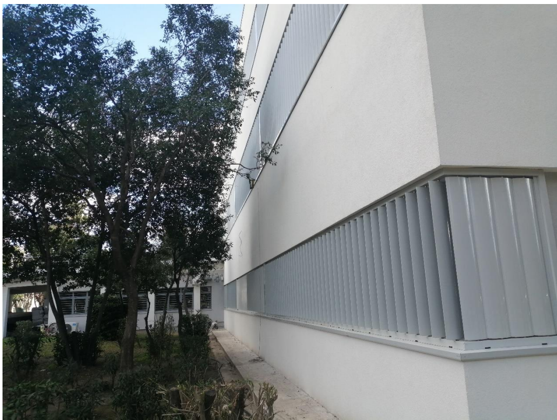
Εικόνα 23 α,β : Όψη λεπτομέρεια του κτιρίου πριν και μετά την αναβάθμιση
