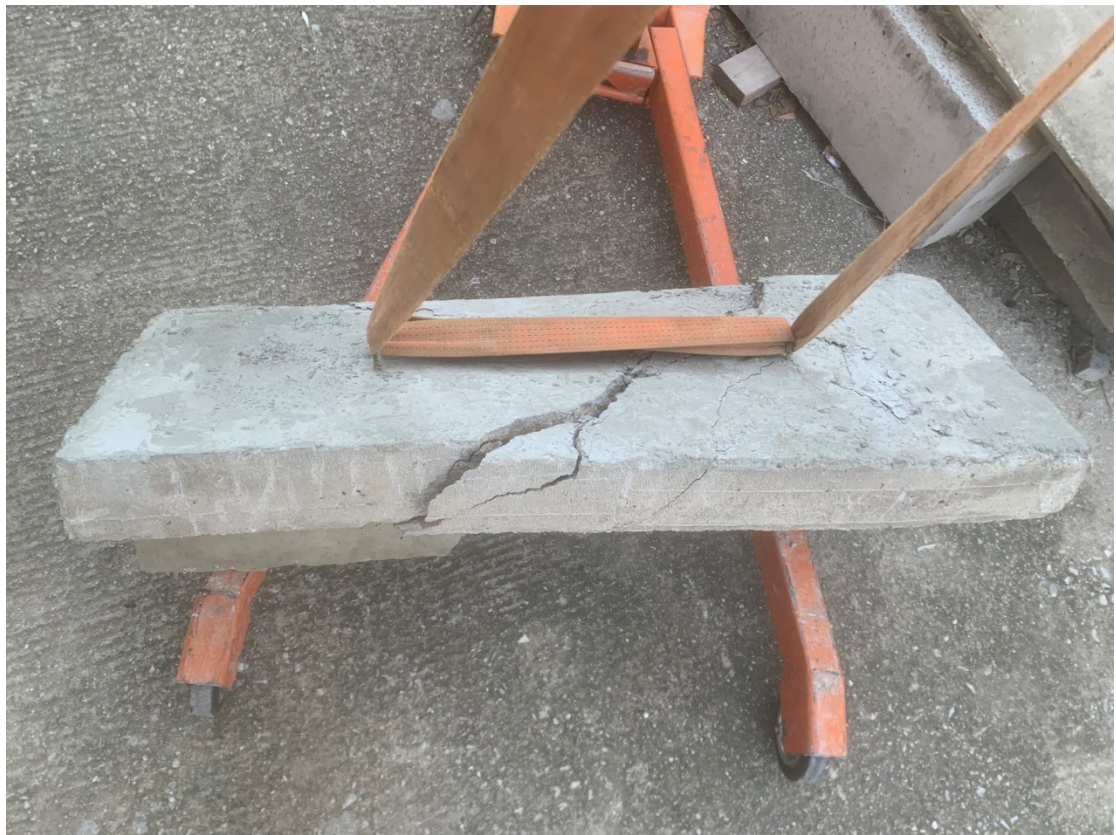
Εικόνα 32-33 : Πλακοδοκός μετά την πειραματική διαδικασία (οπίσθια όψη)
