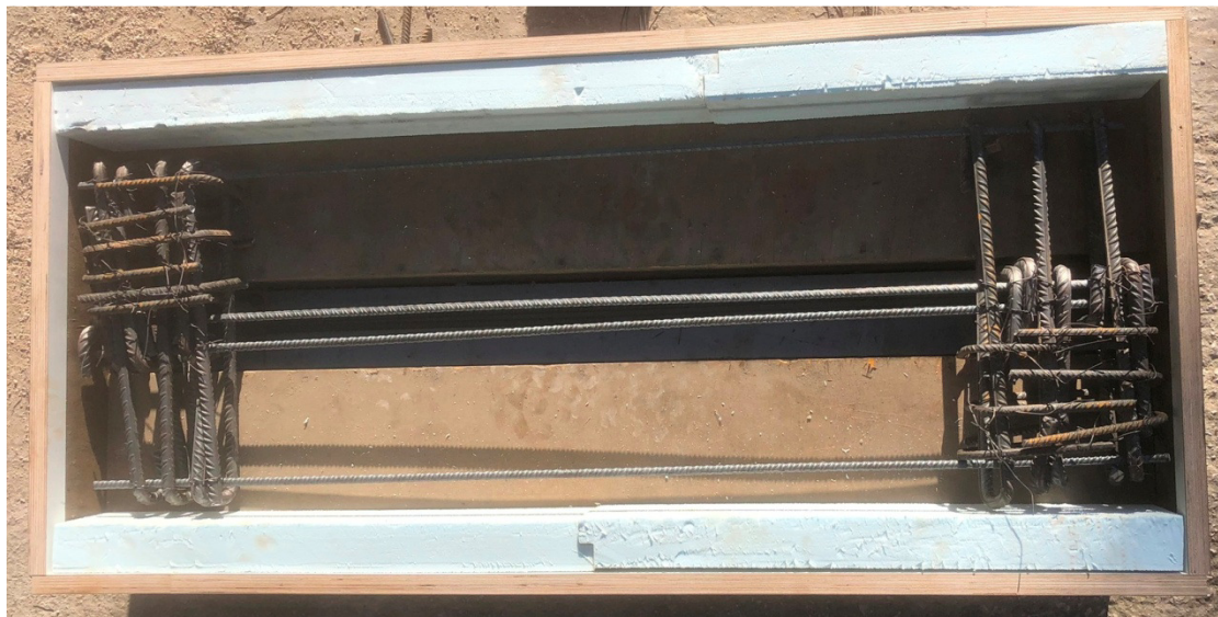
Εικόνα 16-17 : Προετοιμασία σκελετού δοκού TV γ 1/27-11-2022
