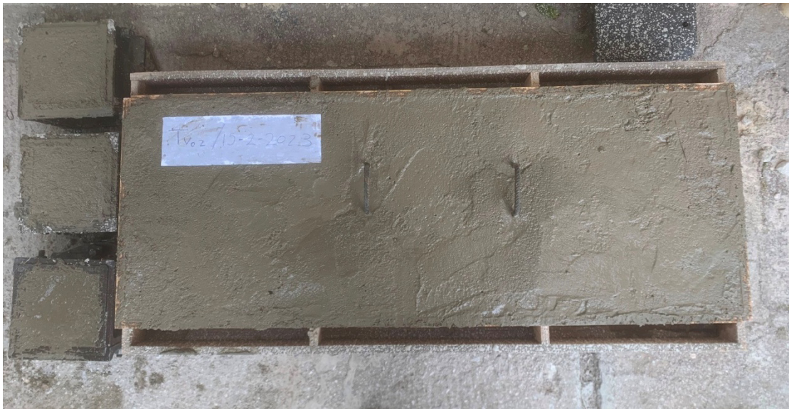
Εικόνα 34 : Σκυροδέτηση δοκού δοκού TV T 2/15-02-2023
