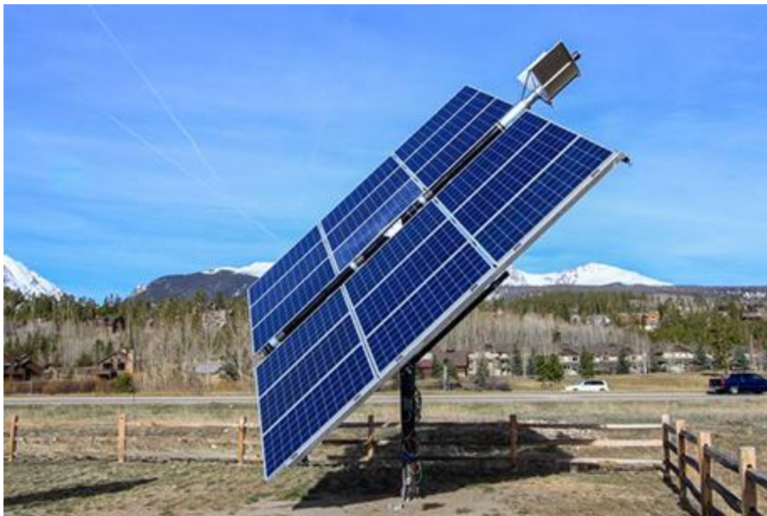
Εικόνα 1.3: Φ/β πλαίσια με αυτόματη ρύθμιση βέλτιστης γωνίας κλίσης [7]
