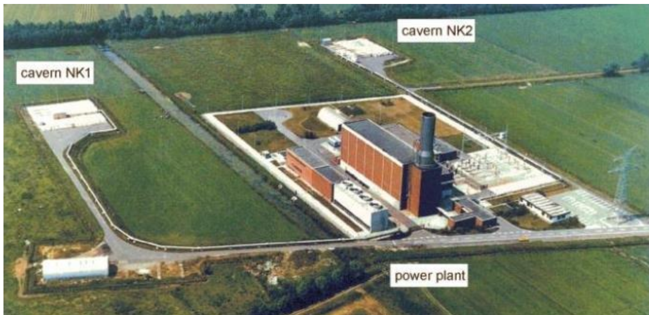
Εικόνα 2.4: Εγκατάσταση CAES στο Hundorf της Γερμανίας
