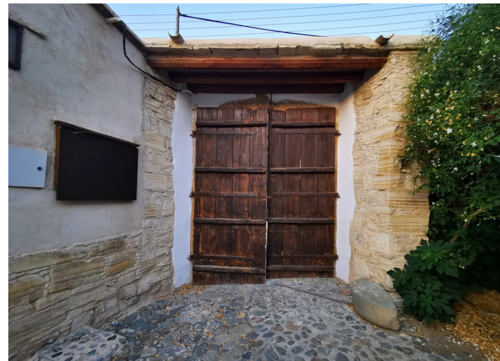
Εικ. 14 Πόρτα εισόδου εσωτερικά
