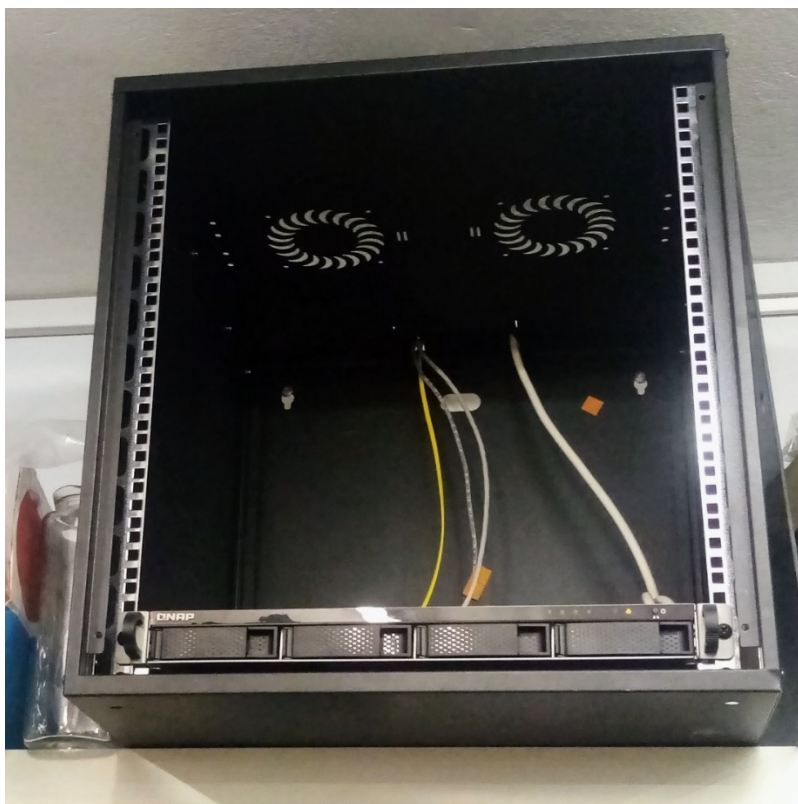
Εικόνα 9 Διακομιστής NAS στο αρχειοστάσιο του ΣΕΠ που εξυπηρετεί τη δημιουργία αντιγράφων ασφαλείας του ψηφιοποιημένου υλικού. Πηγή: οπτικοακουστικό αρχείο ΣΕΠ, προσωπική συλλογή συγγραφέως
