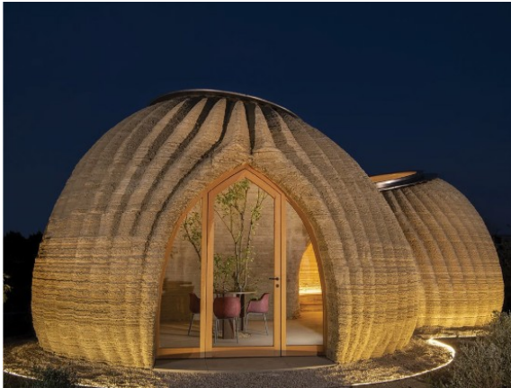
Εικόνα 1: Σπίτια κατασκευασμένα με την μέθοδο τρισδιάστατης εκτύπωσης με σκοπό την βιωσιμότητα. Τα σπίτια είναι κατασκευασμένα με χώμα από την περιοχή. Κατασκευαστής TECLA
