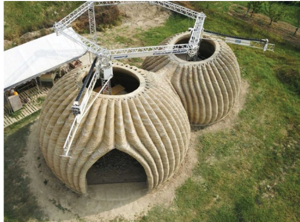
Εικόνα 2: Κατασκευή των βιώσιμων σπιτιών TECLA με την μέθοδο τρισδιάστατης εκτύπωσης. Τα σπίτια κατασκευάζονται με χώμα από την περιοχή.
