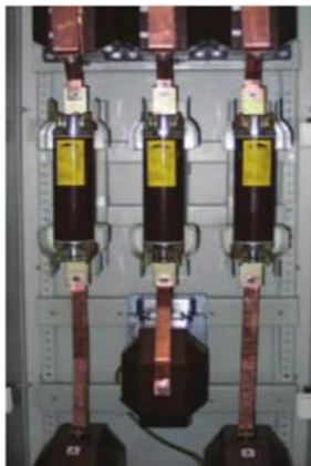
Εικόνα 3 Ασφάλειες Μ.Τ. τύπου κόνεως [6]
