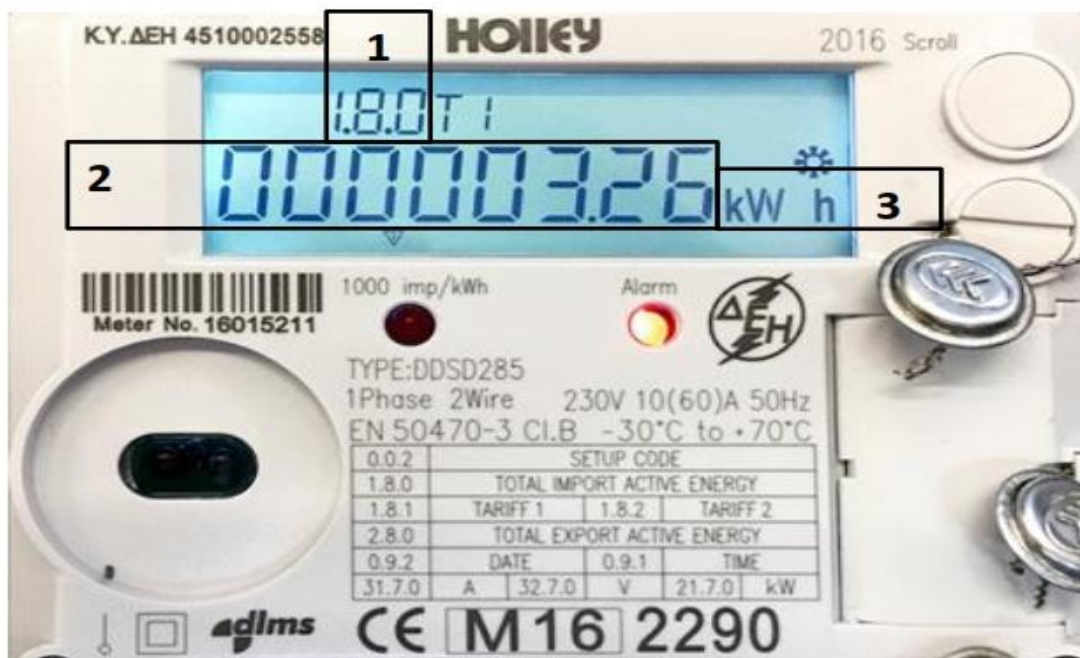
Εικόνα 12 Ενδείξεις ηλεκτρονικών μετρητών ΔΕΔΔΗΕ [16]
