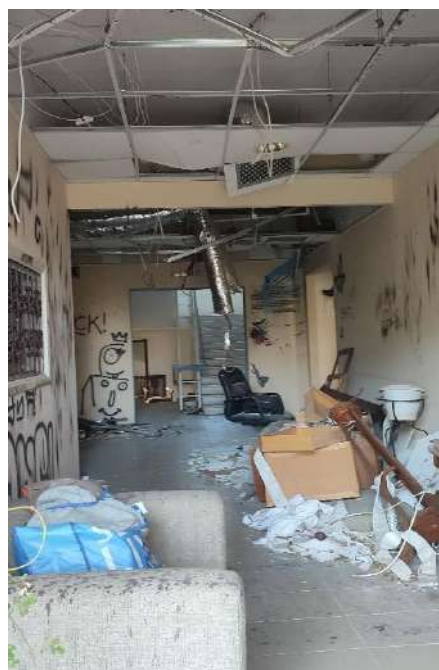
Εικόνα 40 Υφιστάμενη κατάσταση – Χώρος Εισόδου, Προσωπικό αρχείο
