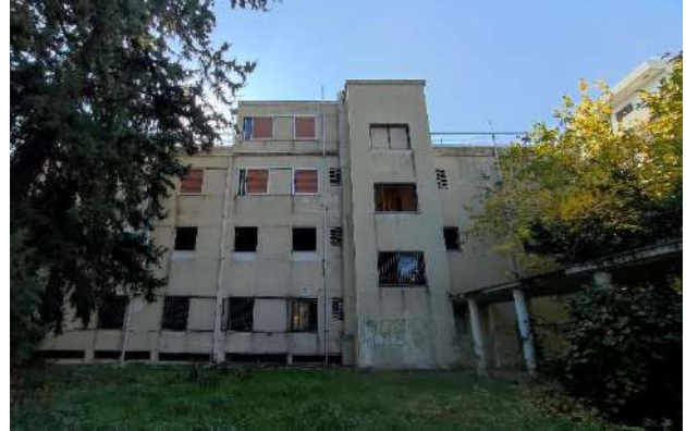
Εικόνα 42 Υφιστάμενη κατάσταση -Βόρεια όψη, Προσωπικό αρχείο
