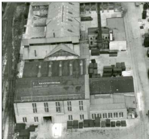
Εικόνα 13: Το παλιό εργοστάσιο δομικού χάλυβα
