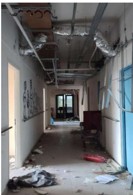
Εικόνα 39 Υφιστάμενη κατάσταση- Εσωτερικός Διάδρομος, Προσωπικό αρχείο
