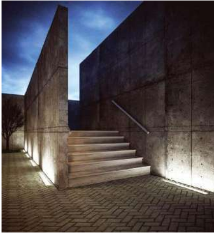
Εικόνα 103: Ενδοδαπέδιος φωτισμός εξωτερικού χώρου
