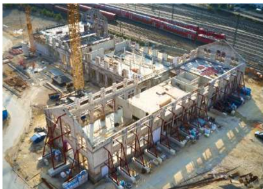
Εικόνα 15: Εργασίες ανακατασκευής του κτηρίου
