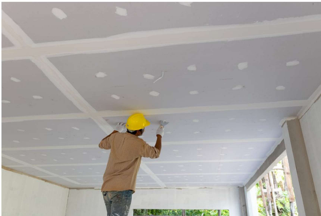
Εικόνα 32: Τεχνική στοκαρίσματος γυψοσανίδας
