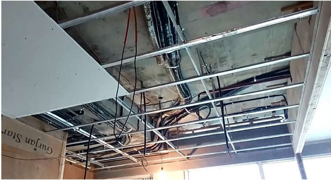
Εικόνα 31: Σκελετός στήριξης γυψοσανίδας
