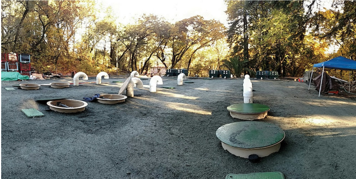
EIKONA 4.1 Το ολοκληρωμένο σύστημα επεξεργασίας λυμάτων του οινοποιείου Castello di Amorosa δείχνει τα συστήματα Orenco Systems και τα συστήματα ανύψωσης και εξαερισμού Xerxes στην κορυφή των δεξαμενών Xerxes 22.000 γαλονιών. (ES&E Magazine (Winery Recycles 1.35 Million Gallons of Water with Napa Green-Certified Wastewater Treatment, June 2019).
