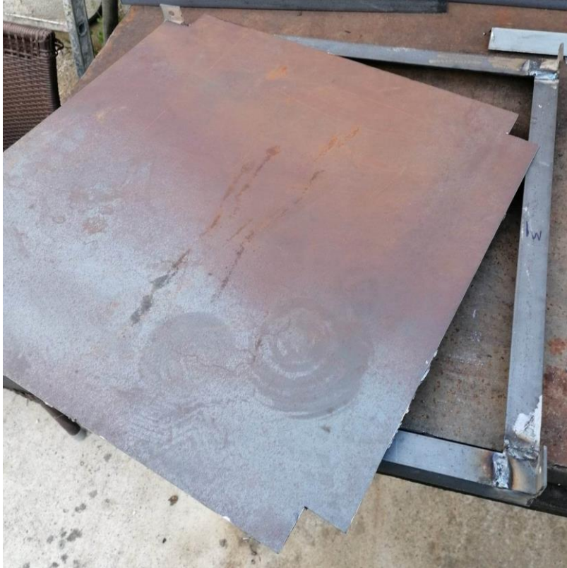
Εικόνα 16: Κόλληση λαμαρίνας 2mm στο περίγραμμα για την κατασκευή του πατώματος.
