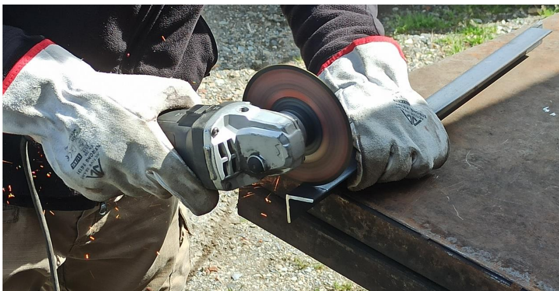
Εικόνα 12: Διαδικασία κοπής μετάλλων για τη κατασκευή του σασί.
