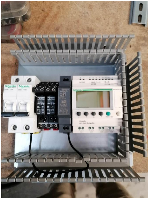
Εικόνα 29: Χτίσιμο δομής πίνακα.
