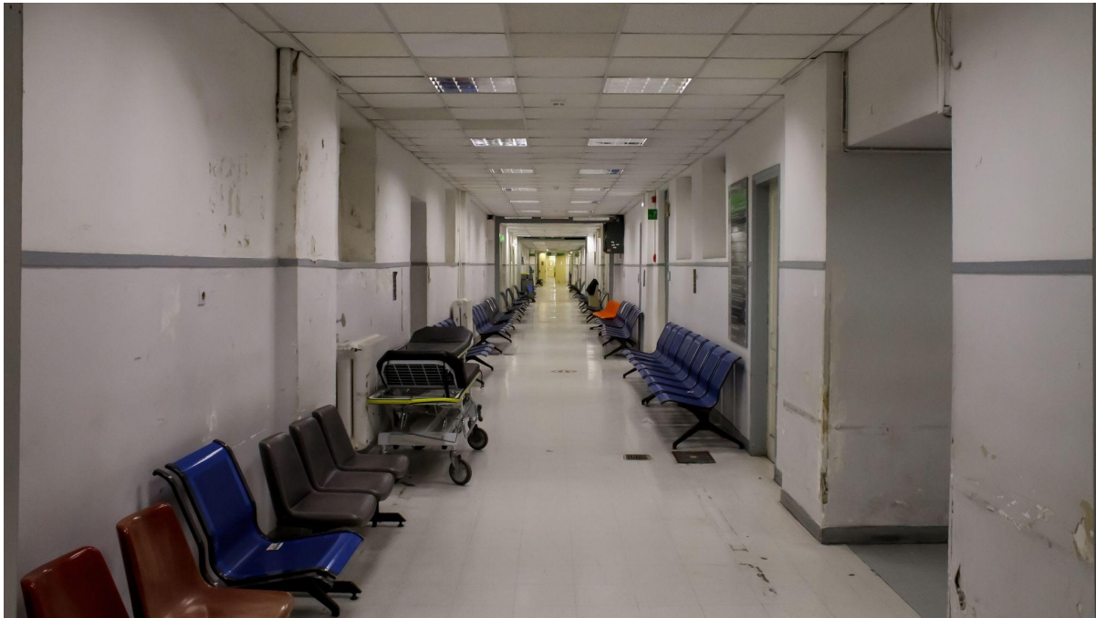
Παλιό κτίριο εξωτερικά ιατρεία, Πέταρ Πετκόβ, 25 Ιουνίου 2023, Αθήνα
