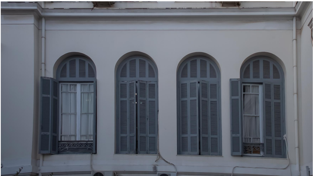
Ο πρώτος όροφος της σύνδεσης του κεντρικού κτιρίου με τα “πλαϊνά”, Πέταρ Πετκόβ, 17 Φεβρουαρίου 2023, Αθήνα
