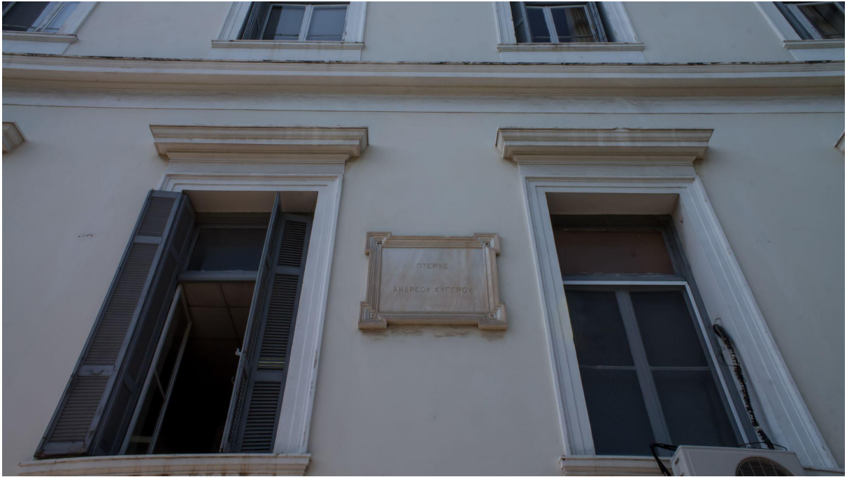
Το δυτικομεσημβρινό κτίριο ή αλλιώς, πτέρυγα Ανδρέα Συγγρού, Πέταρ Πετκόβ, 17 Φεβρουαρίου 2023, Αθήνα
