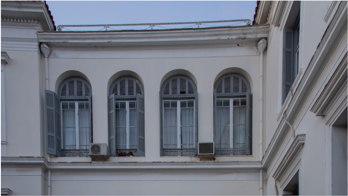
Η προσθήκη της σύνδεσης του κεντρικού κτιρίου με τα “πλαϊνά”, Πέταρ Πετκόβ, 17 Φεβρουαρίου 2023, Αθήνα
