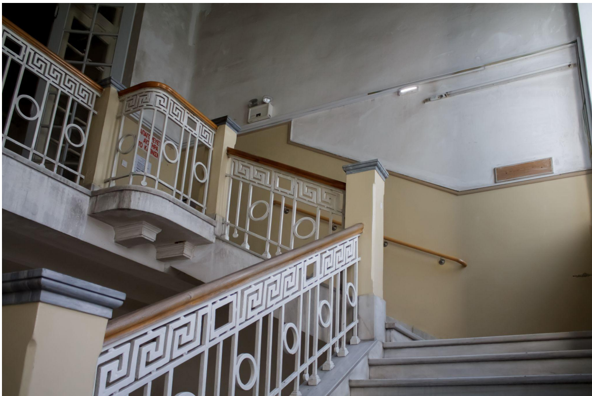
Παλιό κτίριο κλίμακα#3, Πέταρ Πετκόβ, 23 Ιουνίου 2023, Αθήνα
