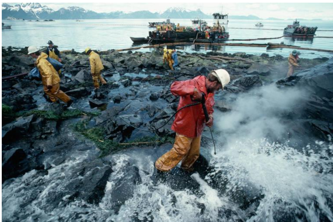
Εικόνα 3: Διαδικασία απορρύπανσης ακτής που έχει μολυνθεί από πετρέλαιο ή παράγωγα του
