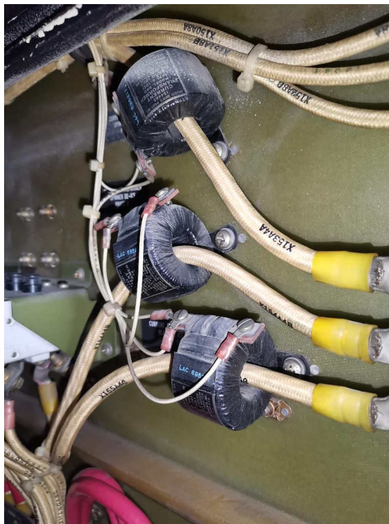
Εικόνα 3.18: Μετασχηματιστές έντασης σε αεροπλάνο.
