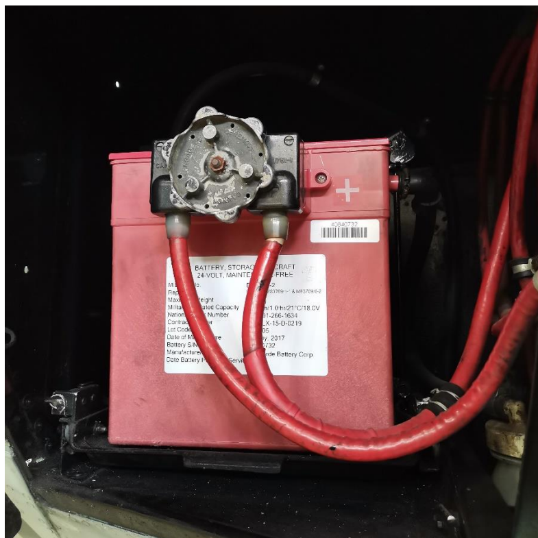
Εικόνα 2.59: Συσσωρευτής οξέων μολύβδου τοποθετημένος επί του αεροπλάνου.
