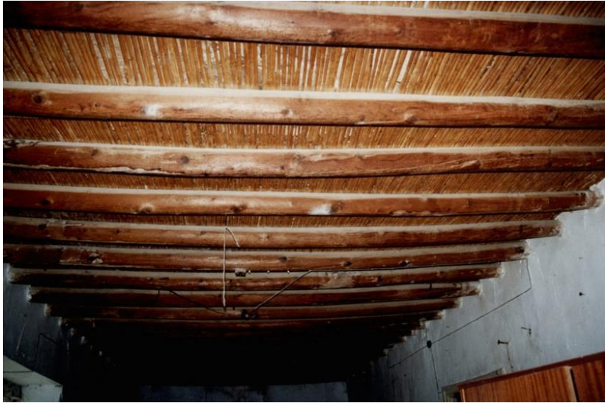
Εικόνα 27: Βολίτζια, χοντρά ξύλα τοποθετημένα στην στέγη
