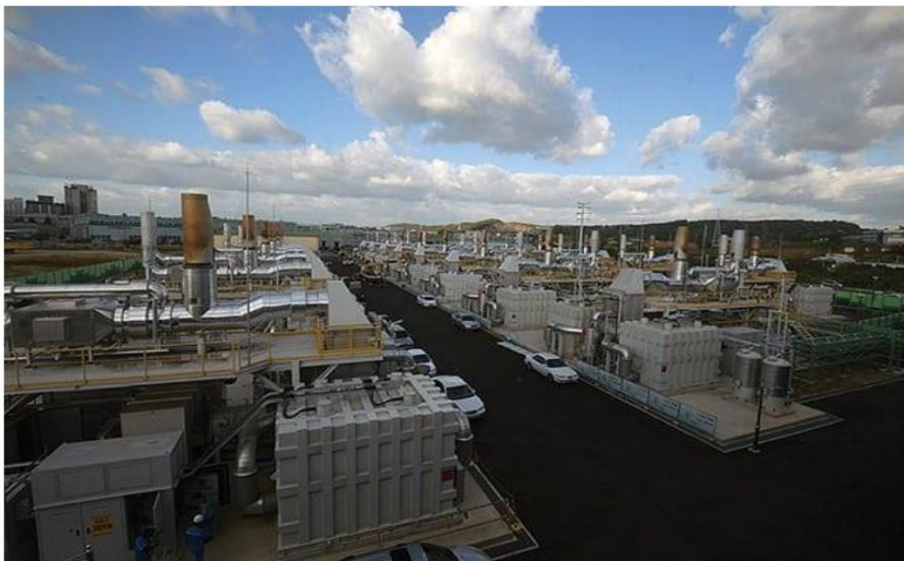
Εικόνα 4-5: Σύστημα αποθήκευσης κυψελών καυσίμου
