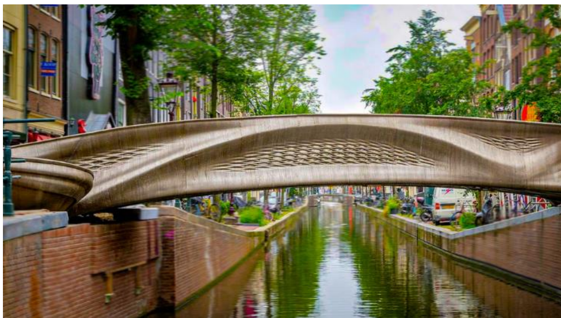
Εικόνα 3.11: Γέφυρα στην Ολλανδία κατασκευασμένη με τη μέθοδο WAAM από την εταιρία MX3D (Schwaar, 2022).
