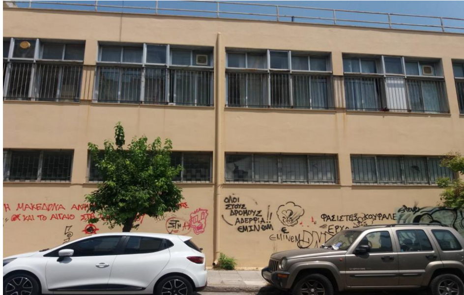
Εικόνα 4: Άποψη από την νότια όψη (πηγή: φωτογραφικό υλικό)
