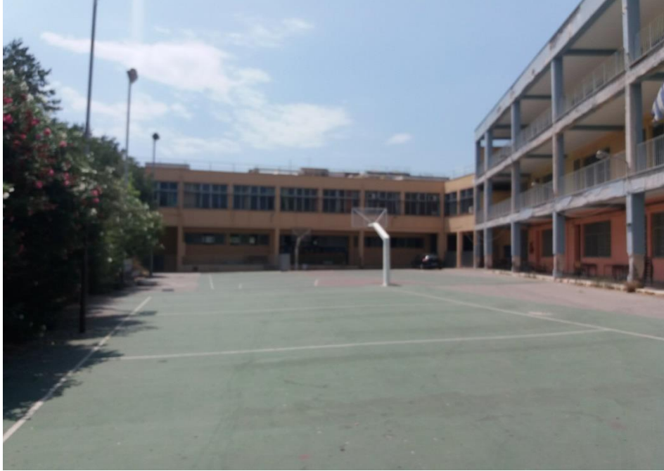
Εικόνα 6: Άποψη από την βόρεια όψη (πηγή: φωτογραφικό υλικό)
