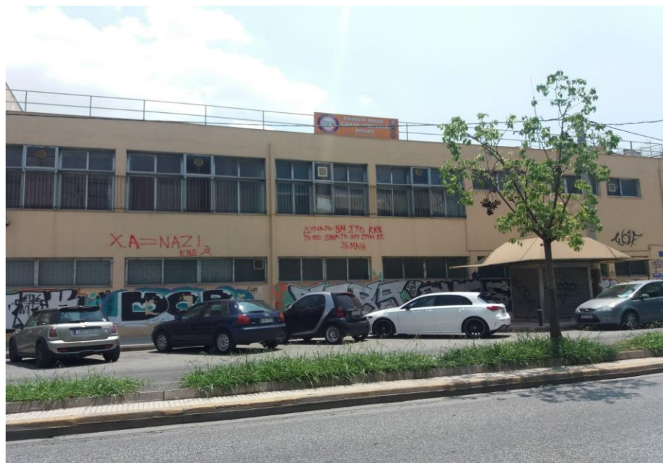
Εικόνα 5: Άποψη από την δυτική όψη (πηγή: φωτογραφικό υλικό)
