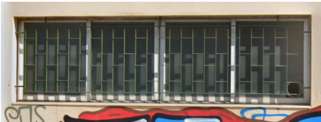
Εικόνα 7: Κουφώματα υφιστάμενου κτηρίου (πηγή: φωτογραφικό υλικό)
