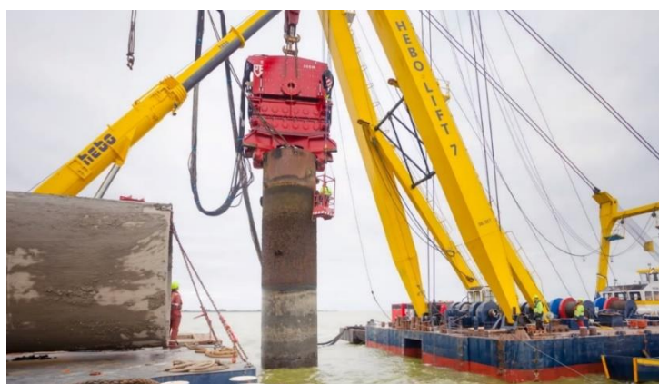
Εικόνα 54: Αφαίρεση θεμελίωσης με κατάλληλο εξοπλισμό. Πηγή: https://www.diesekogroup.com/project/decommissioning-lelv-offshore-wind-farm/
