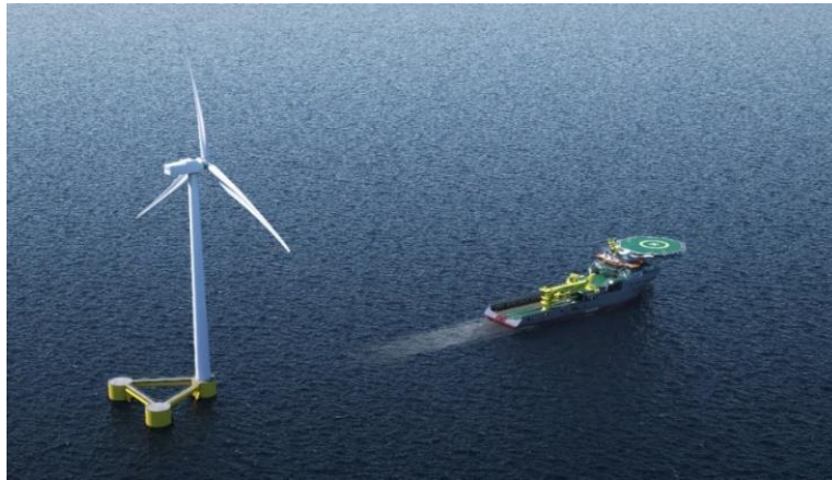
Εικόνα 25: Μεταφορά πλωτής Α/Γ στο σημείο εγκατάστασης με κατάλληλο μέσο. Πηγή:
