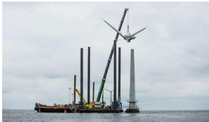
Εικόνα 53: Αφαίρεση ρότορα και πτερυγίων. Πηγή: https://www.offshorewind.biz/2021/06/10/decommissioning-the-last-option-for-offshore-wind-farms-analysis/
