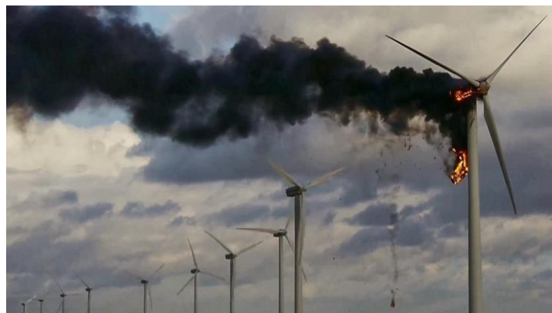
Εικόνα 47: Χαρακτηριστικό παράδειγμα βλάβης στην γεννήτρια . Πηγή: http://guillermo-rein.blogspot.com/2014/01/wind-turbines-on-fire.html
