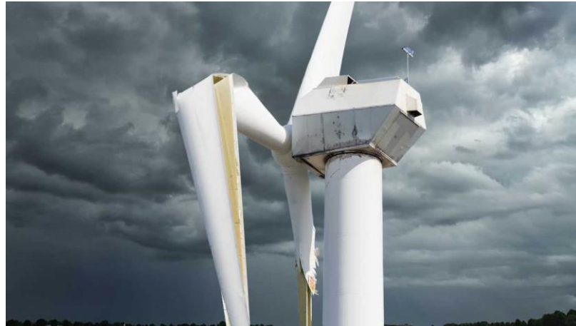
Εικόνα 46 : Χαρακτηριστικό παράδειγμα βλάβης πτερυγίου λόγω βάρους. Πηγή: https://www.windturbinemagazine.com/why-do-wind-turbine-blades-wear-out/
