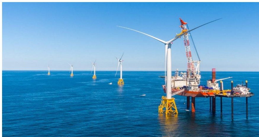
Εικόνα 24: Εγκατάσταση Α/Γ σταθερού πυθμένα. Πηγή : https://medium.com/offshore-wind-energy-the-future/placing-offshorewind-turbines-can-get-technical-what-are-the-criteria-and-limitations-12fb9c06b28a
