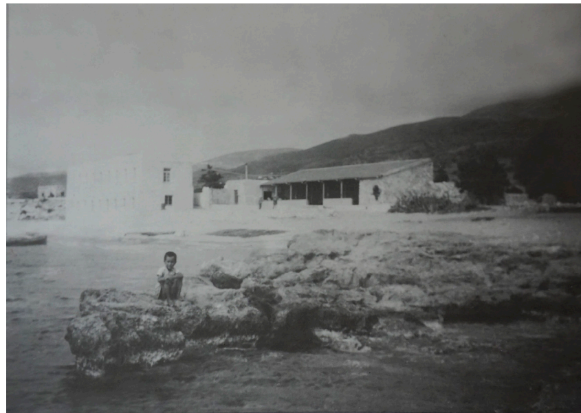
Εικ.27 ο 'Τουριστικός Ξενώνας Δριού' όπως αποκαλούνταν η Φάμπρικα στη δεκαετία του 1960. Στο πρώτο πλάνο οι νεώσοικοι που σχηματίζουν τον Κάβο και φτάνουν ως το λιμανάκι ανατολικά
