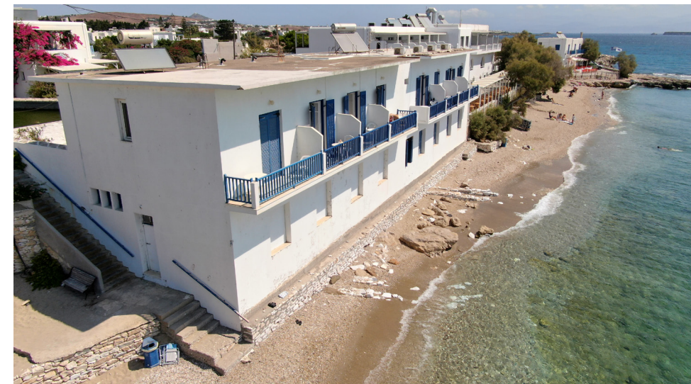
Εικ.12 Κτίριο μελέτης
