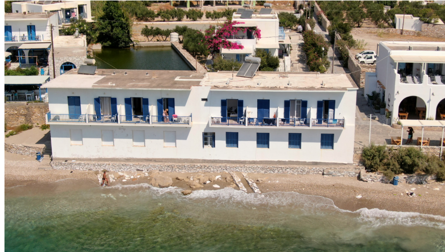
Εικ.13 Κτίριο μελέτης
