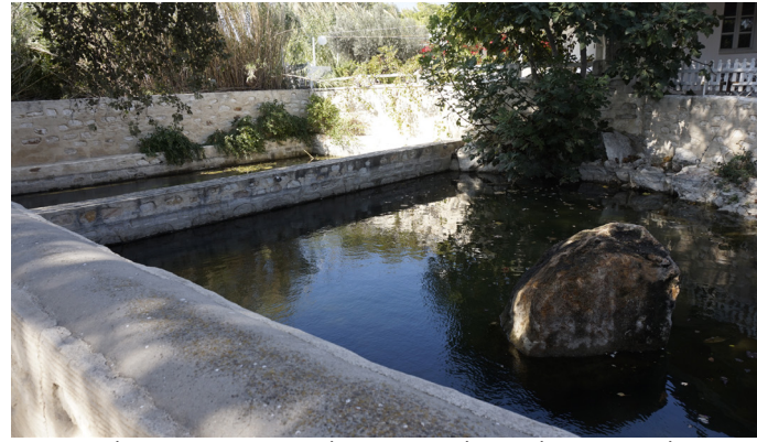
Εικ.7 Πηγή του νερού και πρώτη δεξαμενή νερού κατά σειρά
