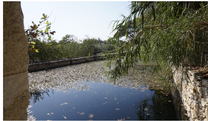
Εικ.8 Δεύτερη δεξαμενή νερού κατά σειρά
