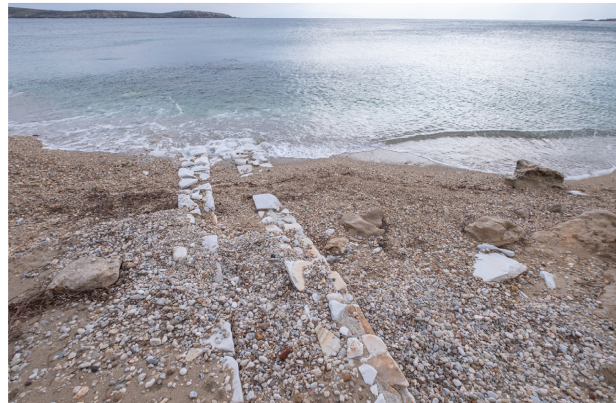
Εικ.14 Ίχνη από τον Αγωγό, κατασκευασμένο από πέτρες και πορσελάνη, όπου χύνονταν τα νερά του υδρόμυλου και χάνονταν στη θάλασσα
