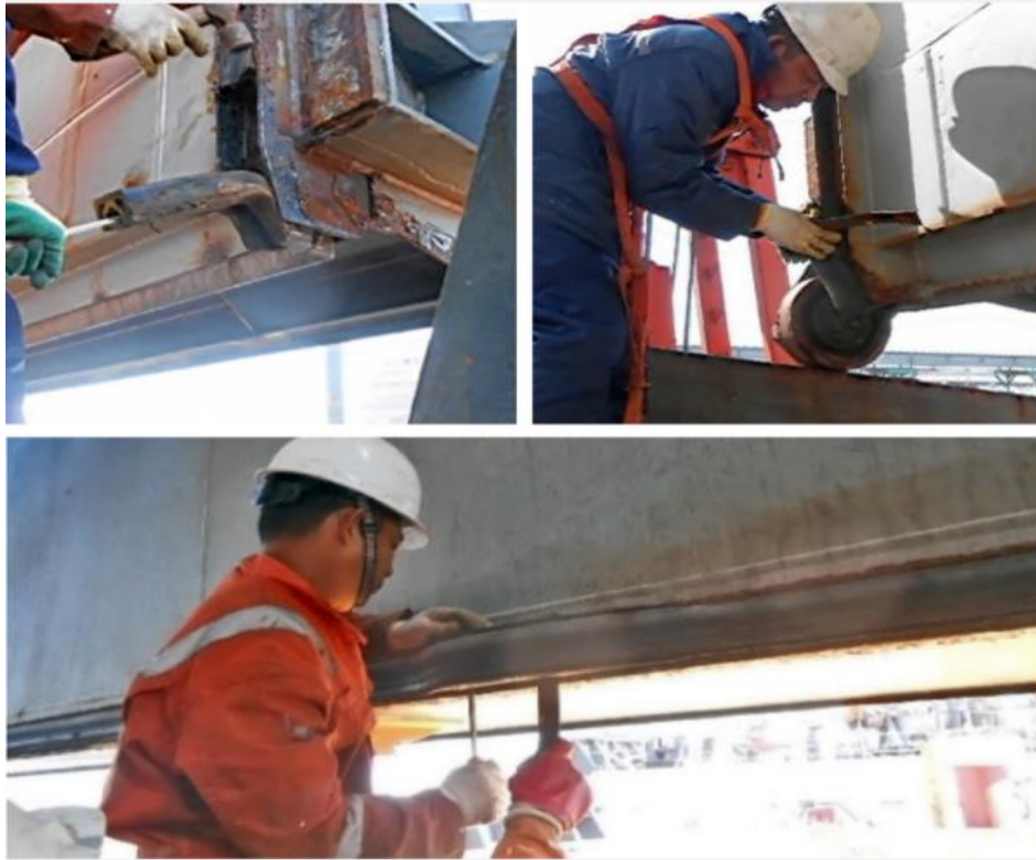
(Εικόνα 3.8: Maintenance of rubber packing / Συντήρηση ελαστικών παρεμβυσμάτων – www.standard-club.com )
