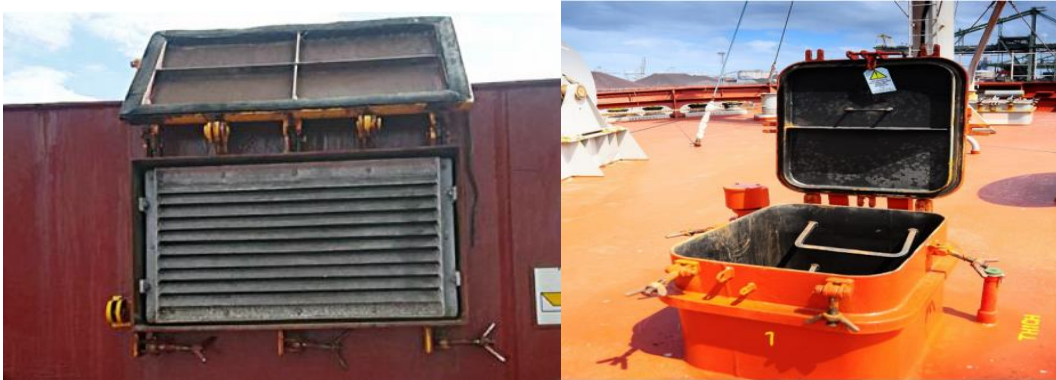
(Εικόνα 3.9: Maintenance of rubber seals on access hatches and ventilators / Συντήρηση ελαστικών παρεμβυσμάτων σε καταπακτές πρόσβασης και εξαεριστήρες – www.standard-club.com )
