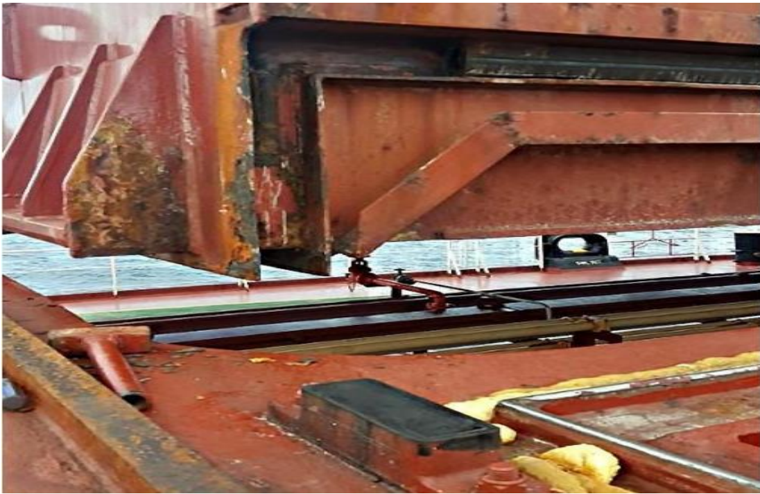
(Εικόνα 3.11: Maintenance of gasket channels / Συντήρηση ενός καναλιού παρεμβύσματος – www.standard-club.com )
