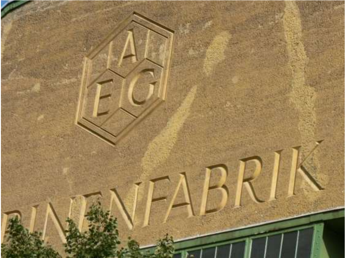
Εικόνα 22. Εργοστάσιο στροβίλων AEG Λογότυπο και επιγραφή στο Αέτωμα (Πηγή: Windsor 1981)
