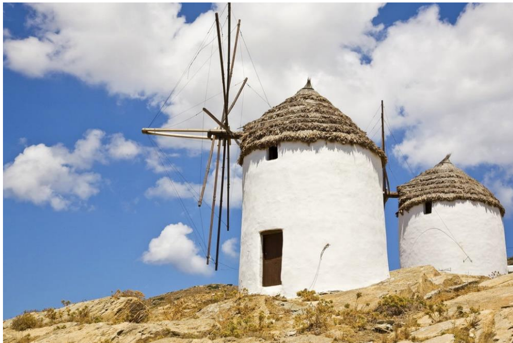
Εικόνα 26 , Προέκταση του άξονα και οι αντέντες.
