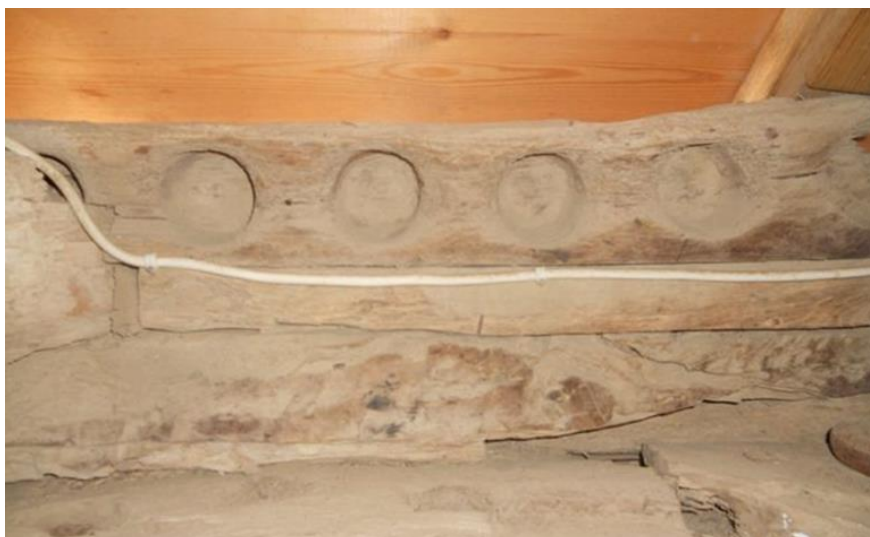
Εικόνα 24 , Ειδικοί κύλινδροι για την στροφή με λοστό.
