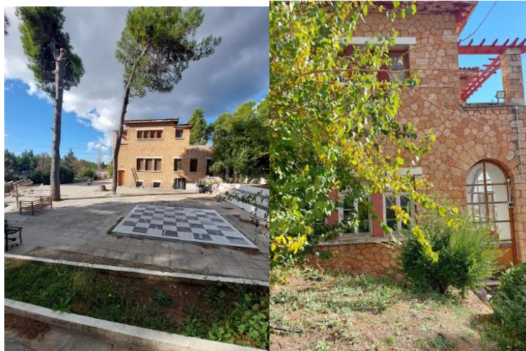
Εικόνα 14: Δυτική και Ανατολική όψη κτηρίου
