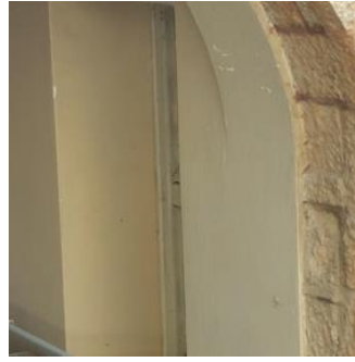
Εικόνα 20: Επιχρισμένο τμήμα βόρειας πλευράς και επενδυμένο τμήμα δυτικής όψης
