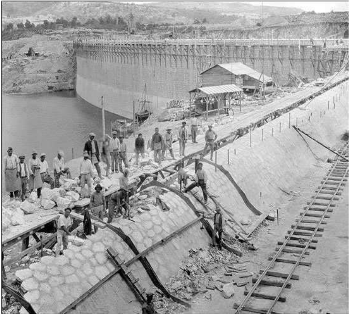
Εικόνα Νο.4: Εν εξελίξει κατασκευή φράγματος.
