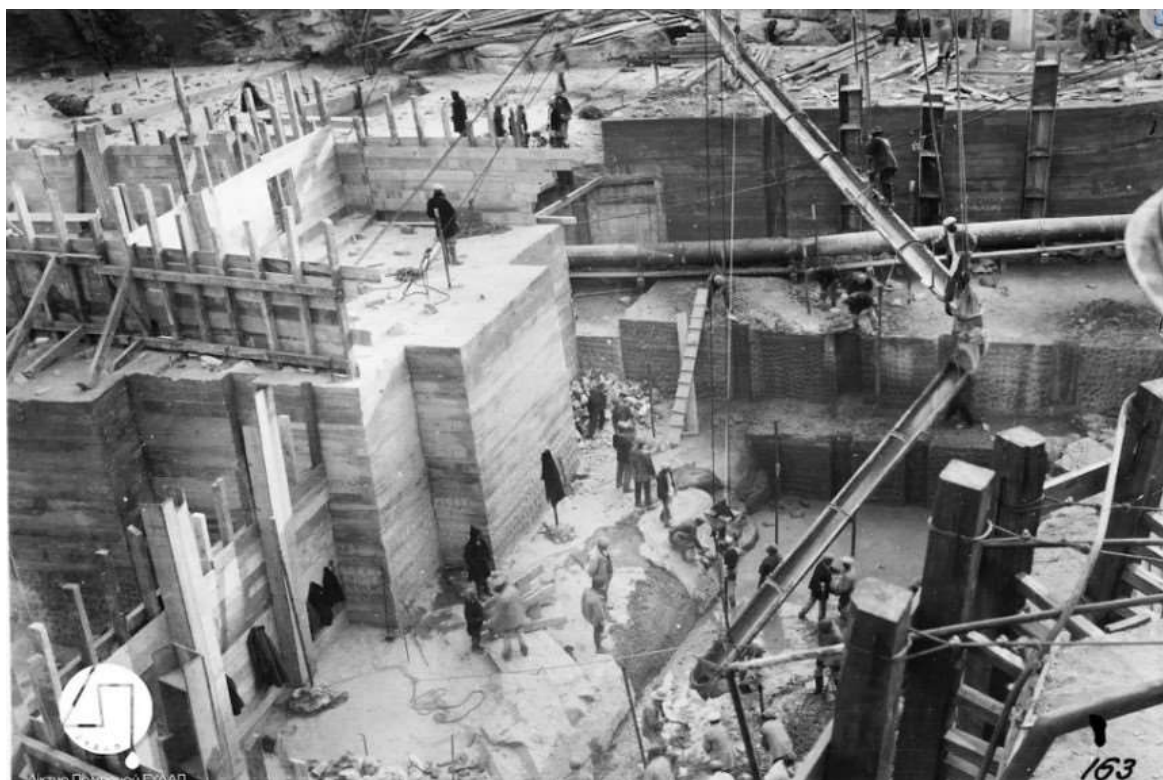
Εικόνα Νο.2: Εν εξελίξει κατασκευή φράγματος. (Δίκτυο Πολιτισμού ΕΥΔΑΠ, 1927).
