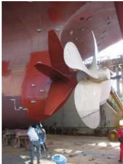
Εικόνα 10: Εγκατάσταση στάτορα στην προπέλα πλοίου για βελτίωση της απόδοσης[23]
