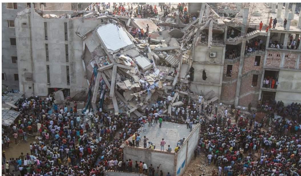
Εικόνα 4: Κατάρρευση κτηρίου Rana Plaza
