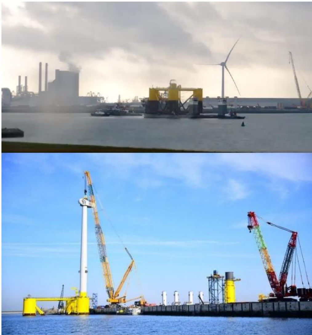
Εικόνα 34: Ενσωμάτωση ημι-βυθιζόμενου πλωτήρα και ανεμογεννήτριας στις εγκαταστάσεις SIF (Ρότερνταμ). [27] [28]
