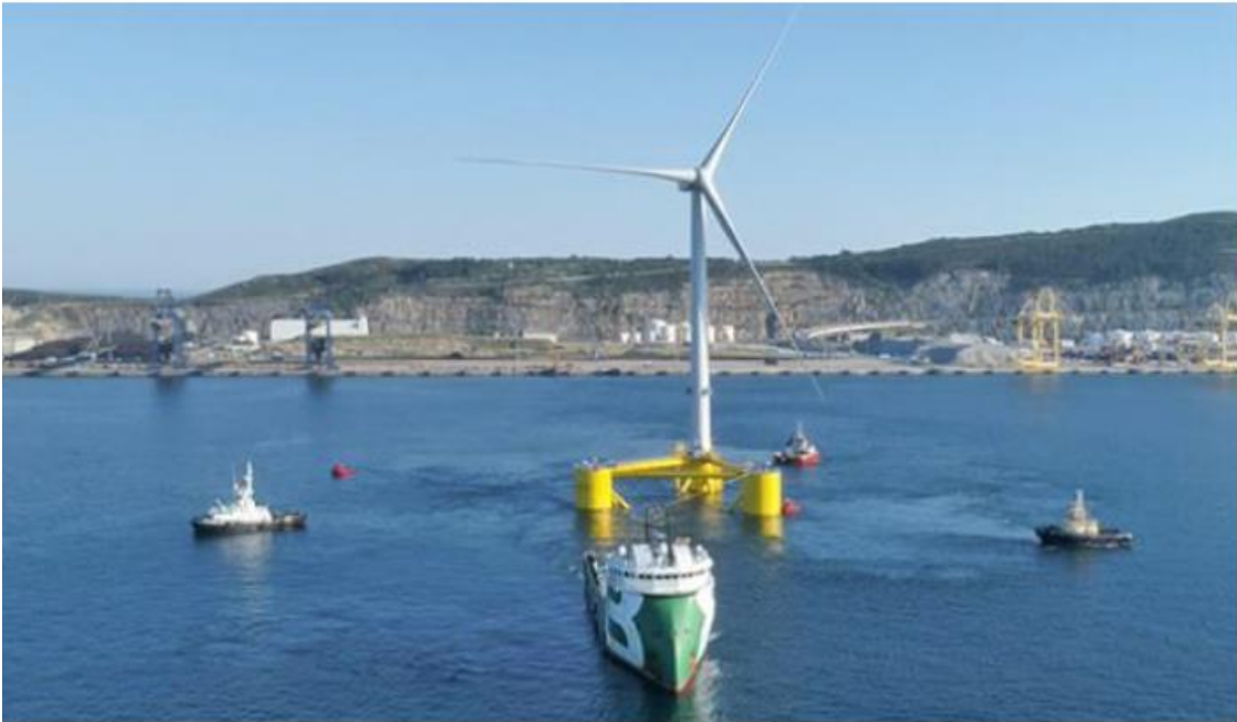
Εικόνα 36: Υγρή ρυμούλκηση ολοκληρωμένου πλωτήρα-Α/Γ από την εγκατάσταση ενσωμάτωσης σε τοποθεσία εγκατάστασης. [30]
