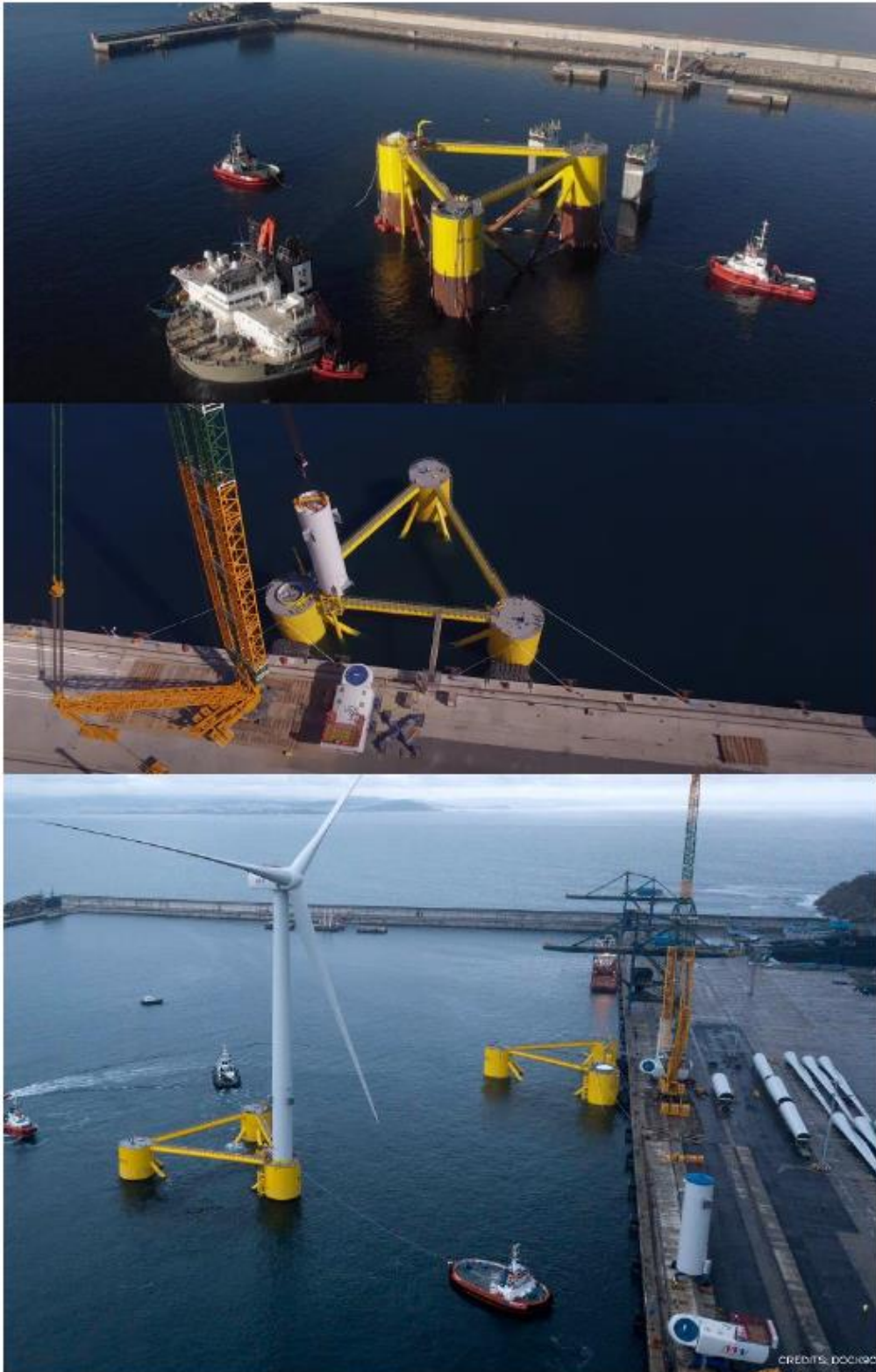
Εικόνα 35:Ενσωμάτωση πλωτήρα – Α/Γ για το έργο WindFloat Atlantic στο Ferrol. [29]
