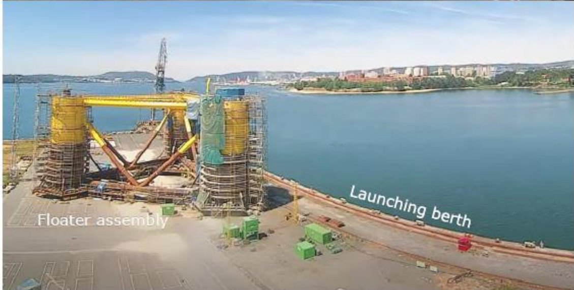
Εικόνα 15: Κατασκευή εξαρτημάτων ημι-βυθιζόμενων πλοητών στις εγκαταστάσεις της Navantia (Ferrol) για το έργο WindFloat Atlantic. [20]
