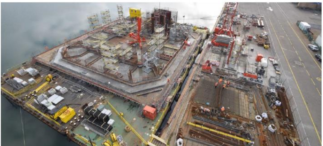
Εικόνα 18: Κατασκευή Ideol floatgen σε φορτηγίδα. [22]
