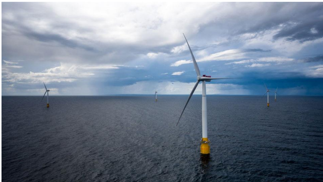
Εικόνα 37: Hywind Scotland σε λειτουργία, με χαλύβδινα θεμέλια. Πηγή: Øyvind Gravås/Woldcam/Statoil ASA.
