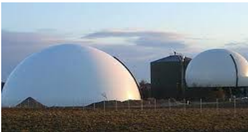
Εικόνα 6. Μονάδα αναεροβίωσης για παραγωγή βιοαερίου
