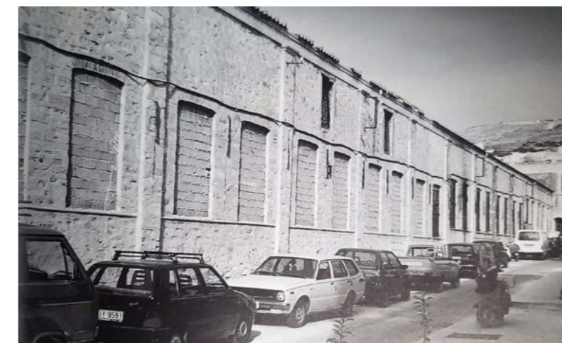
Εικόνα 38 <<Εργοστάσιο Φουστάνου-Καρέλλα-Βελισσαροπούλου στην γωνία των οδών, φωτ. 1998>>
