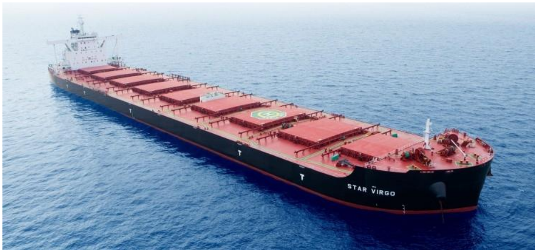
Εικόνα: Dry Bulk Carrier. Οι καθαρές και επίπεδες επιφάνειες του καταστρώματος, προσφέρουν τη δυνατότητα ασφαλούς προσέγγισης CUAVs (Πηγή: www.bairdmaritime.com 12/10/2020)
