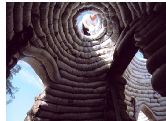
Εικόνες 3.3.3., 3.3.4.: Κατασκευή καταφυγίου με τη μέθοδο Super Adobe στο Ahwaz, Iran ( https://www.akdn.org/architecture/project/sandbag-shelters )
